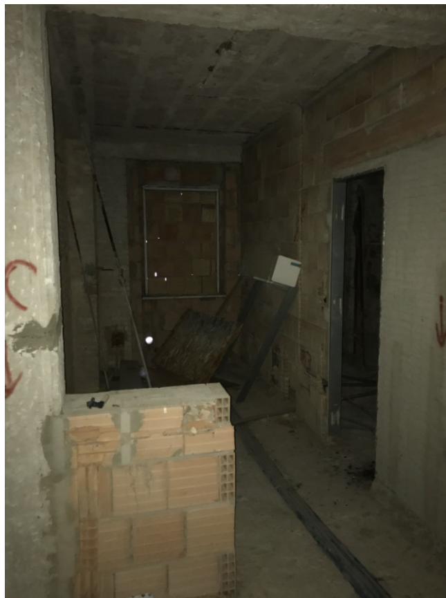
Foto n. 9: vista della cucina e del WC
