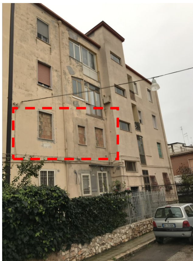
Foto nn. 1 e 2: vista da via Montessori (ingresso)
