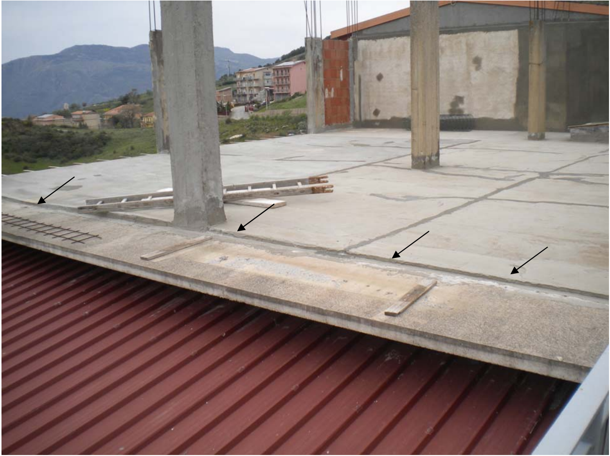
Foto n.13 – Soletta a sbalzo ( da demolire )
