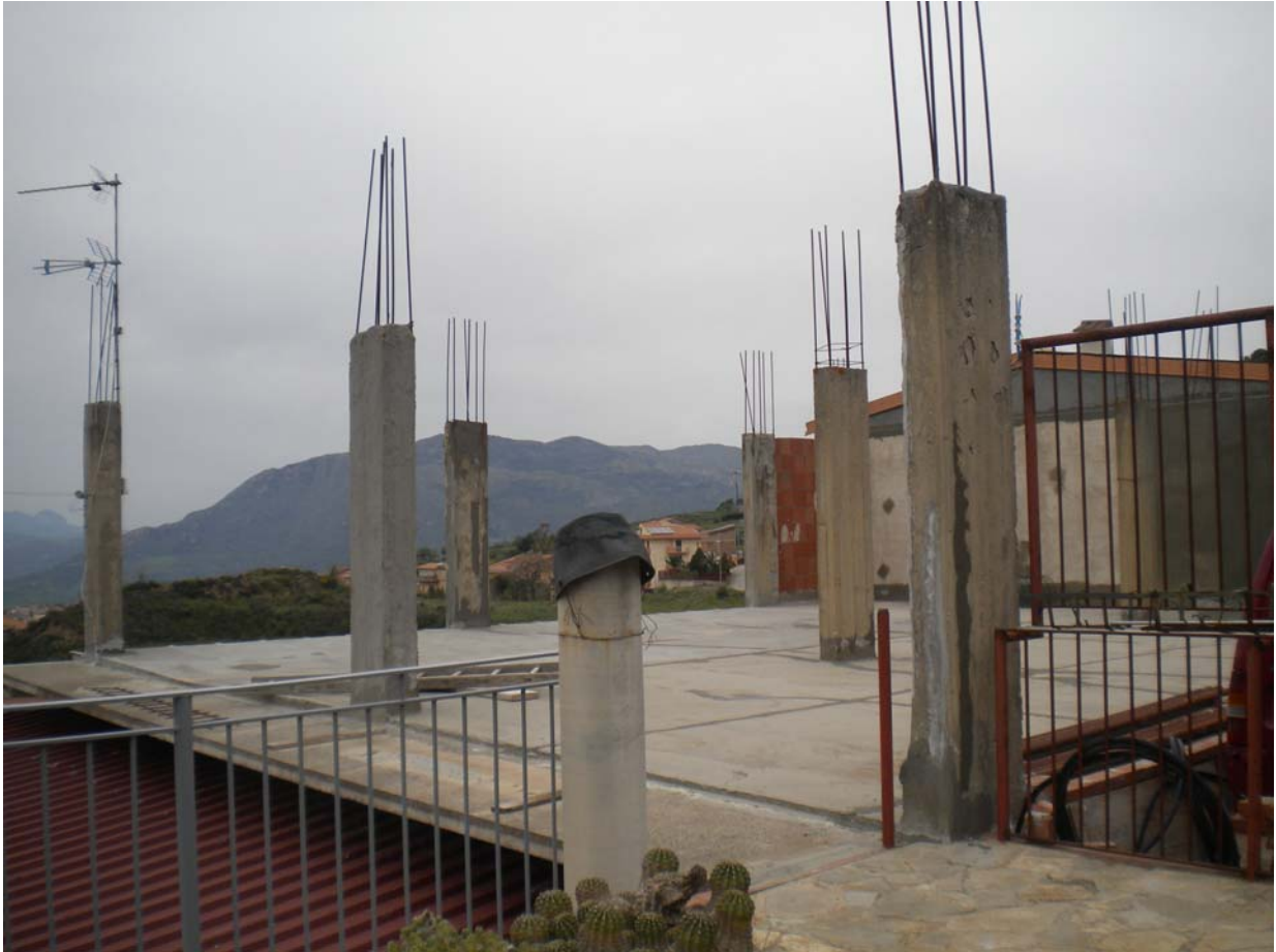
Foto n.5 – Spiccato dei pilastri al terrazzo superiore
