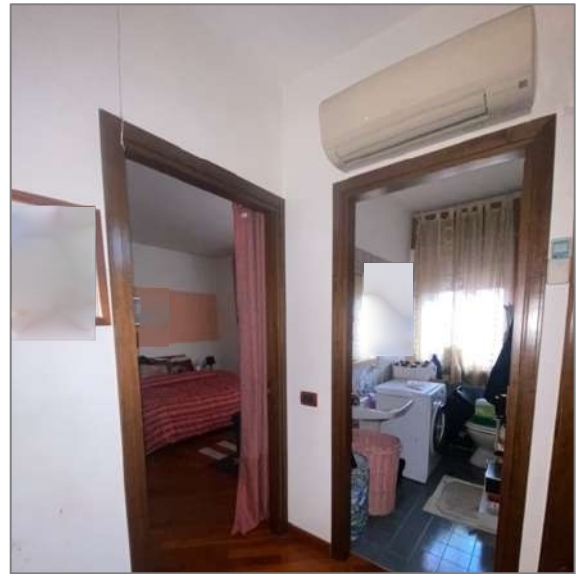
Foto 21. Split nel disimpegno zona notte
