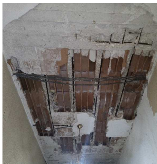
Foto n. 4-5: sfondellamento del solaio in corrispondenza del soprastante bagno
