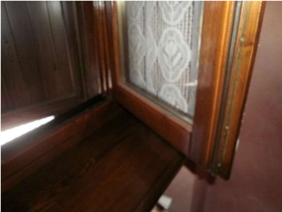
Vista tipologia serramenti esterni a servizio dei vani di abitazione
