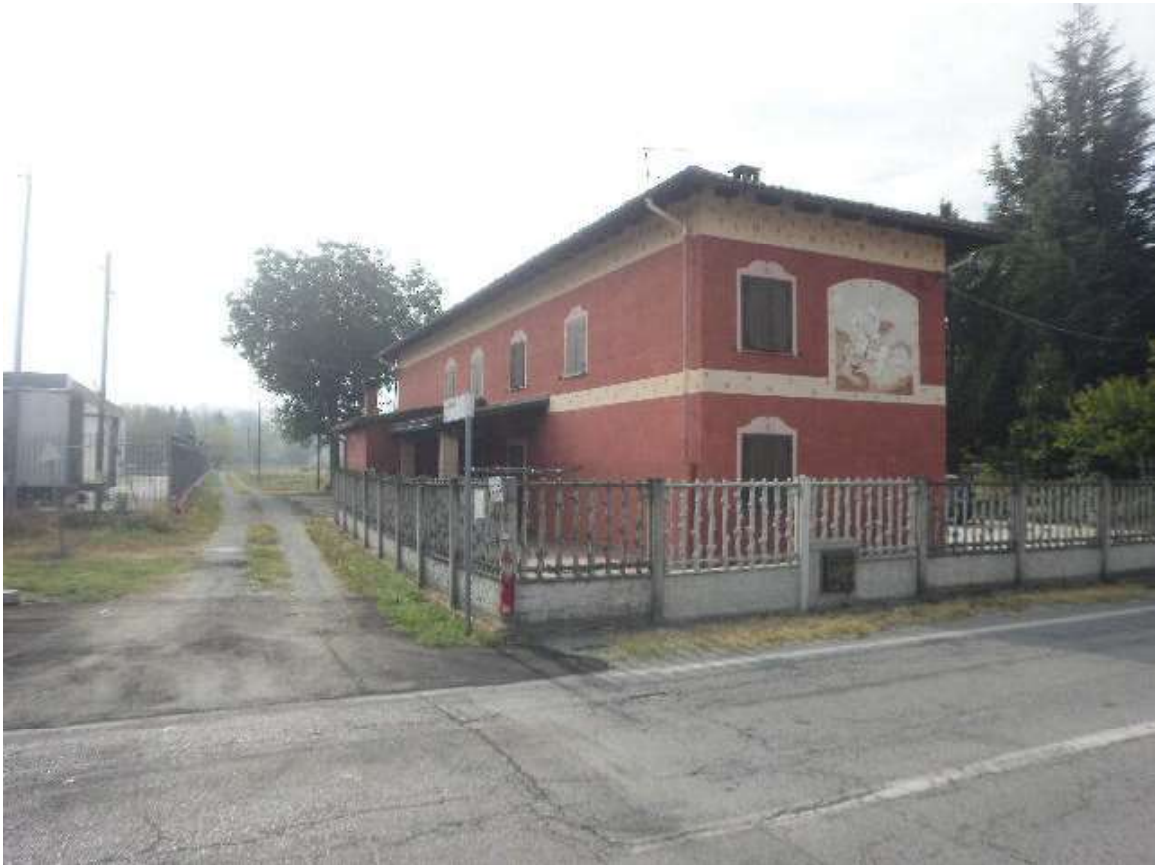
Vista dalla sede stradale pubblica del fabbricato di civile abitazione e suoi accessi
