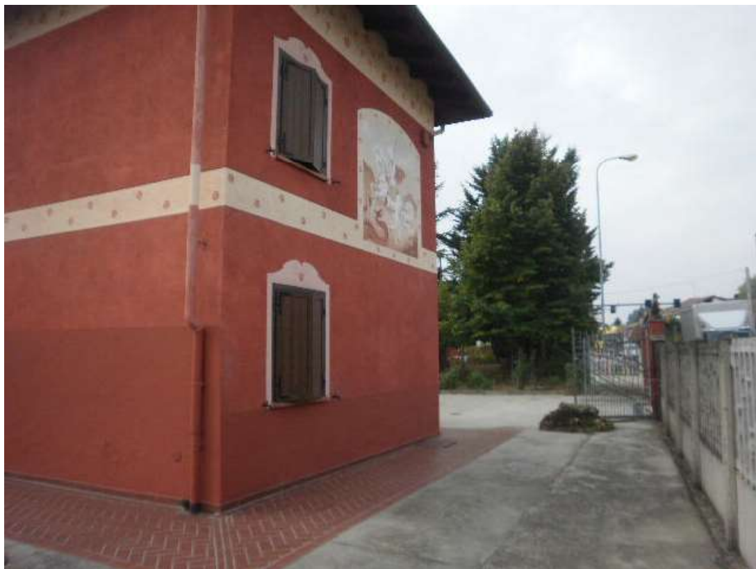
Vista dei corpi accessori al fabbricato principale di civile abitazione
