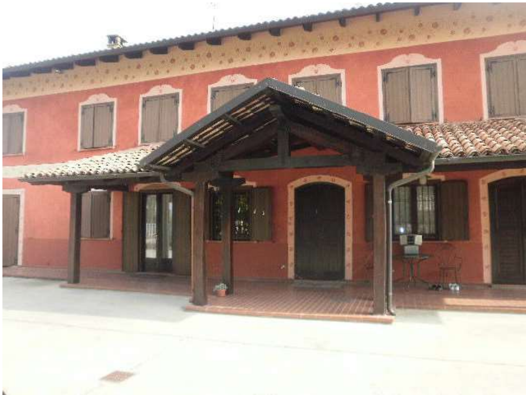
Vista dall'area cortilizia pertinenziale del fabbricato di civile abitazione
