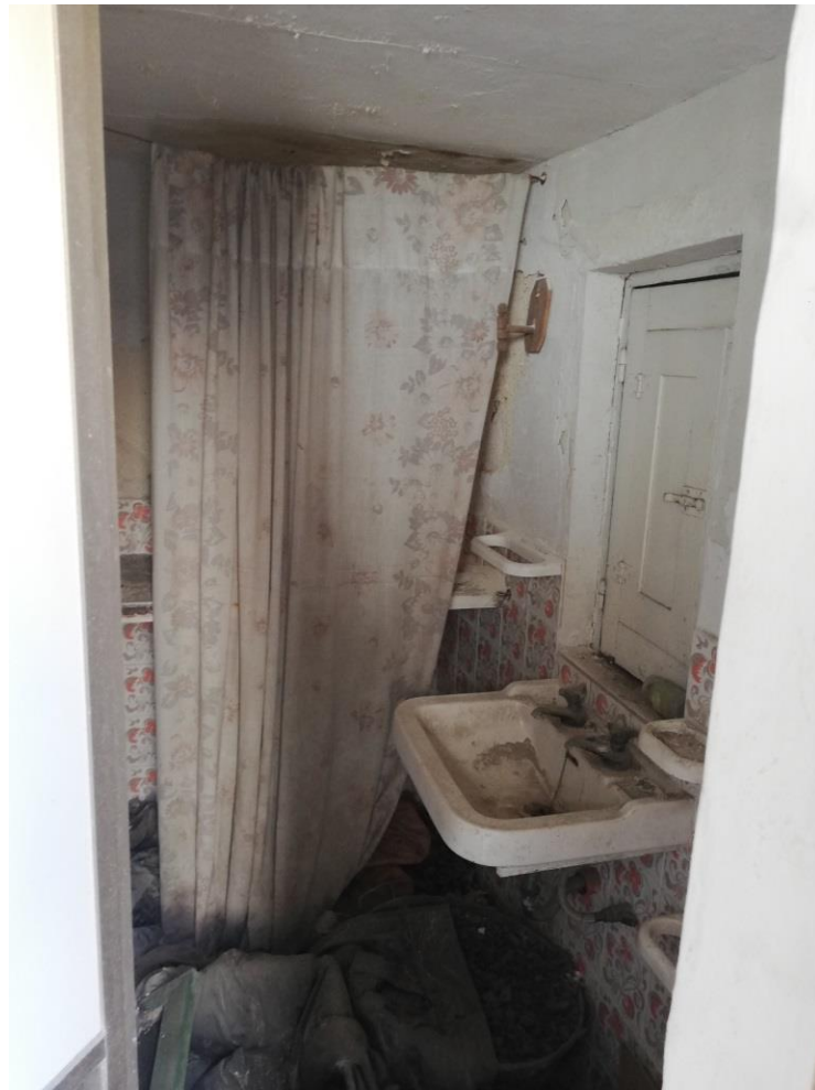
Foto 5 – Interno immobile “B”, bagno
