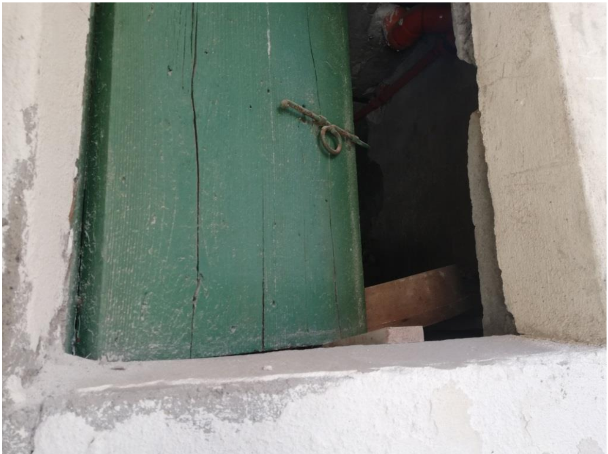
Foto 6 – Interno immobile “B”, piccolo ammezzato al di sopra del bagno
