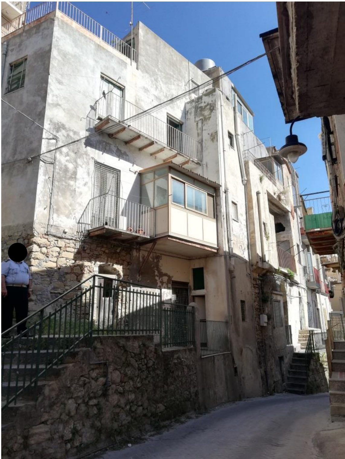
Foto 2 – Prospetto retrostante del fabbricato
