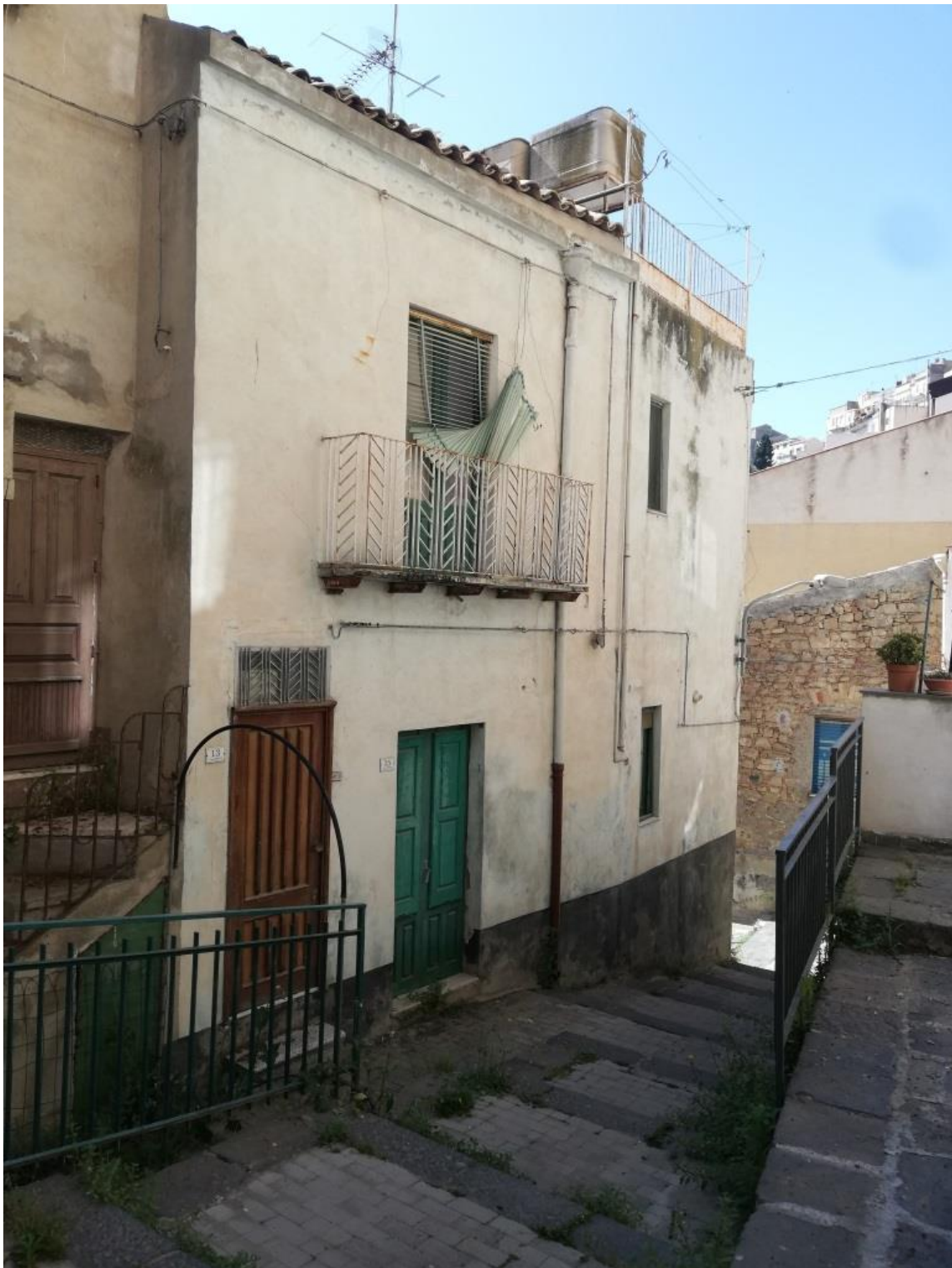
Foto 1 – Prospetto principale del fabbricato
