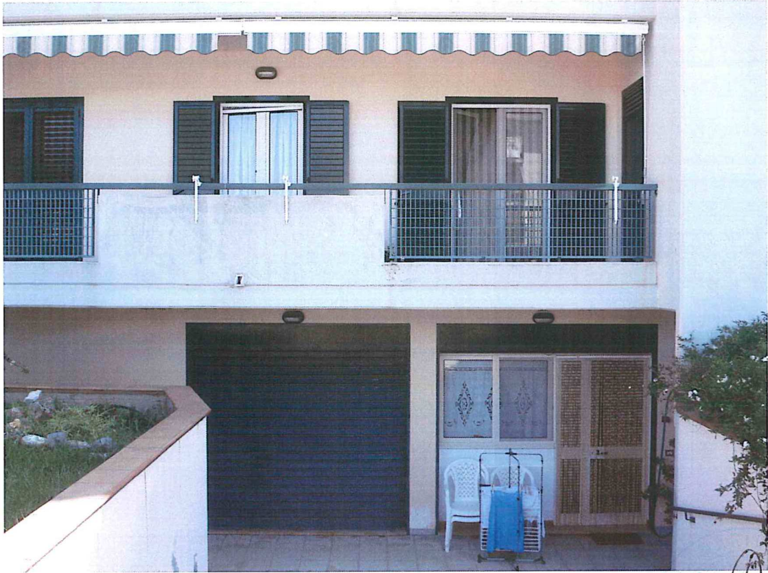
FOTO N.4 ESTERNO RIPRESA INGRESSO PIANO SEMINTERRATO VIA ANZIO
