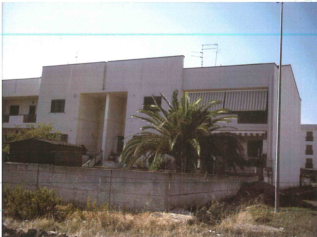
FOTO N.2 ESTERNO GIARDINO POSTERIORE INGRESSO VIA ANZIO - RIPRESA DA EST A OVEST
