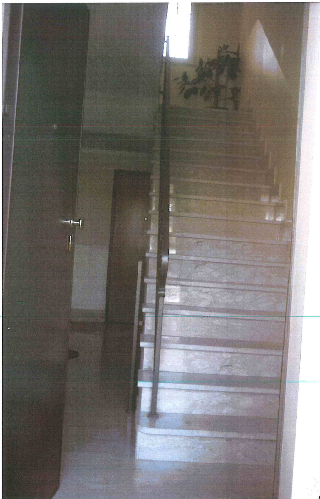
FOTO N.14 INTERNO VANO SCALA COMUNE
