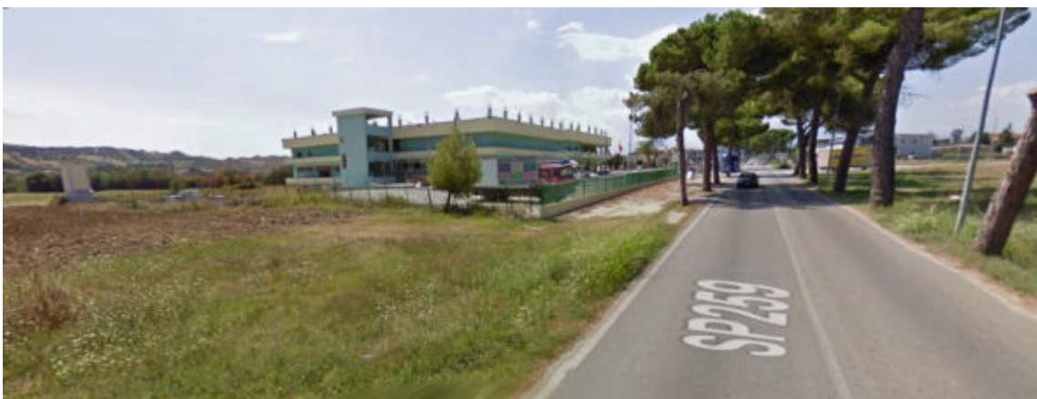
foto n. 2 – Vista Edificio Commerciale da SP259, lato Nord-Est
