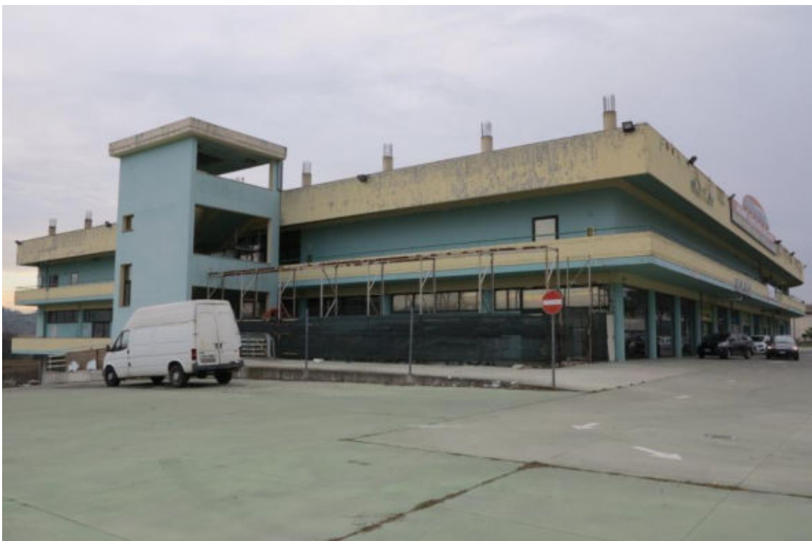
foto n. 3 – Vista Edificio Commerciale lato Nord-Est
