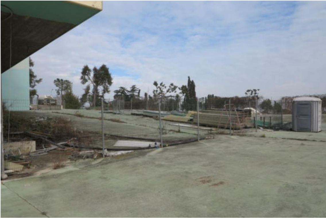
foto n. 12 – Vista lato Est
