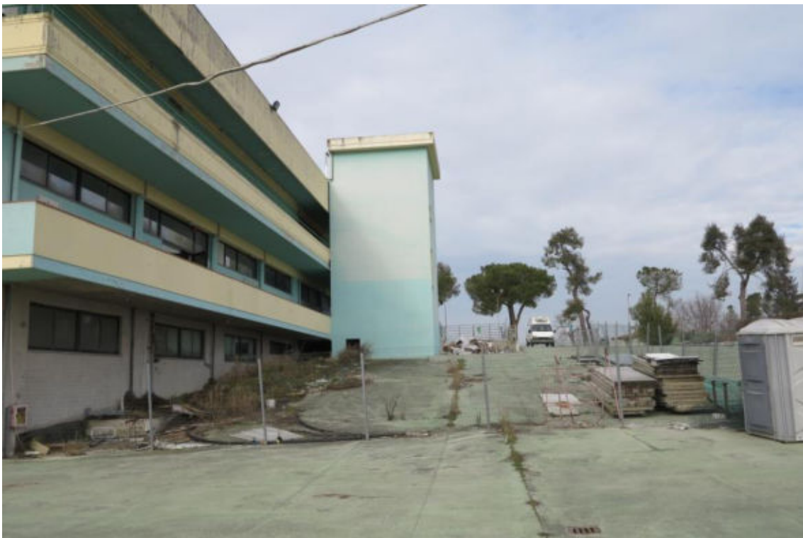
foto n. 11 – Vista lato Est
