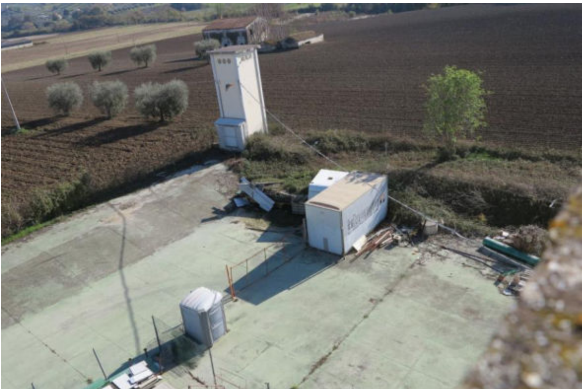
foto n. 13 – Vista lato Est – Cabina Enel
