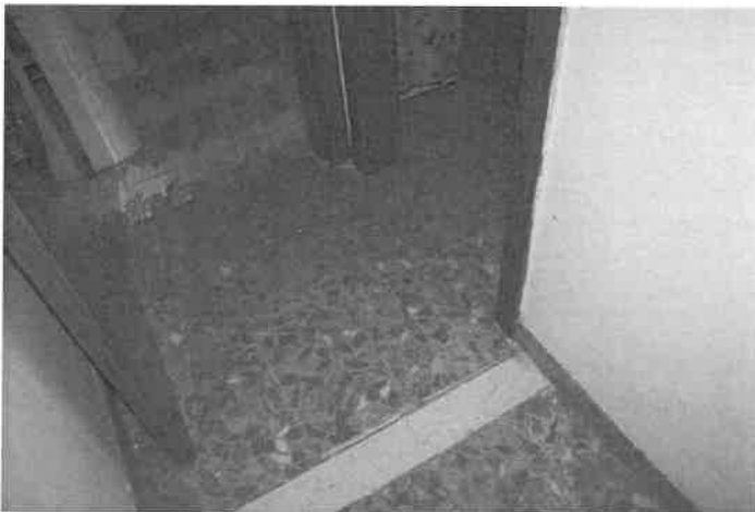
Foto n°50 pavimento tra corridoio, cucina e bagno
