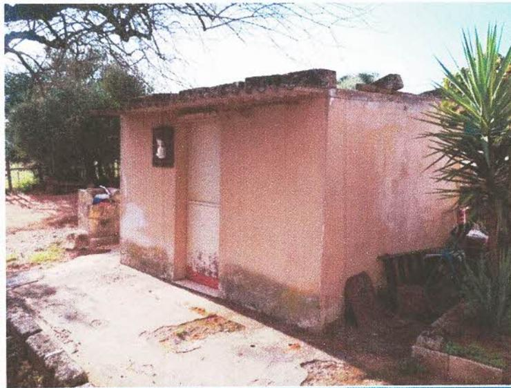
**Copertura del locale magazzino con lastre di eternit**
