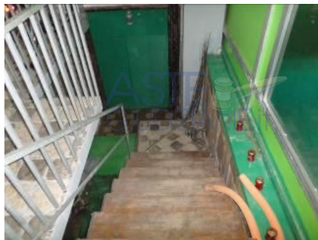
Area di accesso al secondo piano seminterrato
