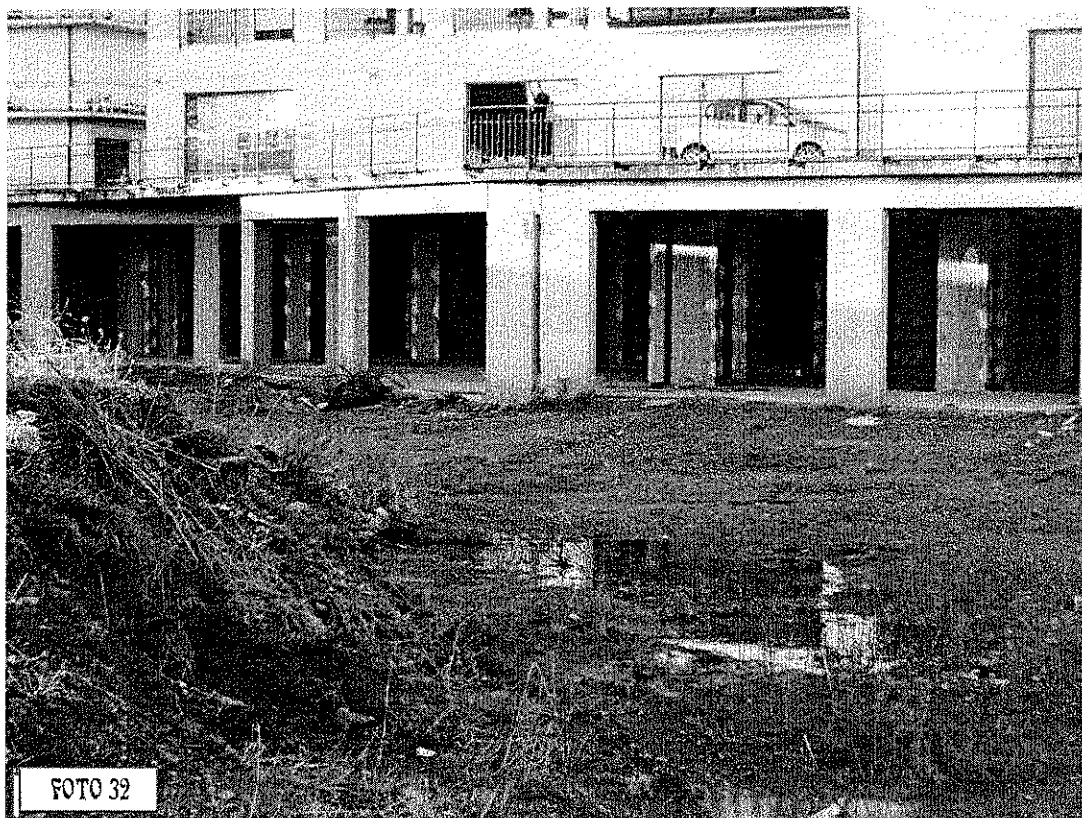
Lotto N. 5: Piano Seminterrato, ulteriore veduta del prospetto Sud; in primo piano porzione i beni in esame.
