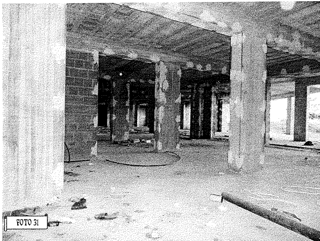
Lotto N. 5: Piano Seminterrato, vista dei locali contigui a quello in esame, privi di pareti di divisione.
