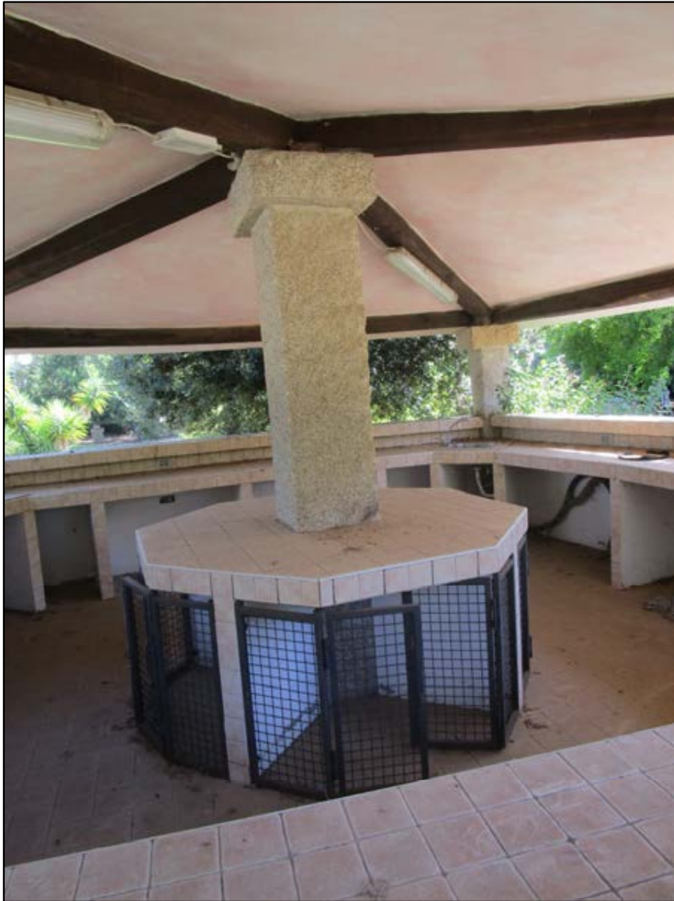
Foto 43: particolare edificio adibito a bar
