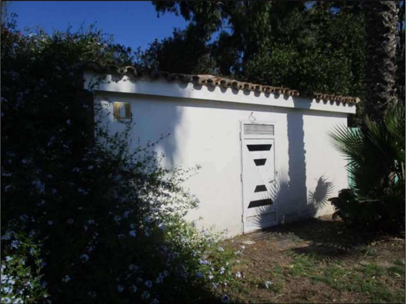
Foto 37: edificio ospitante le celle frigo
