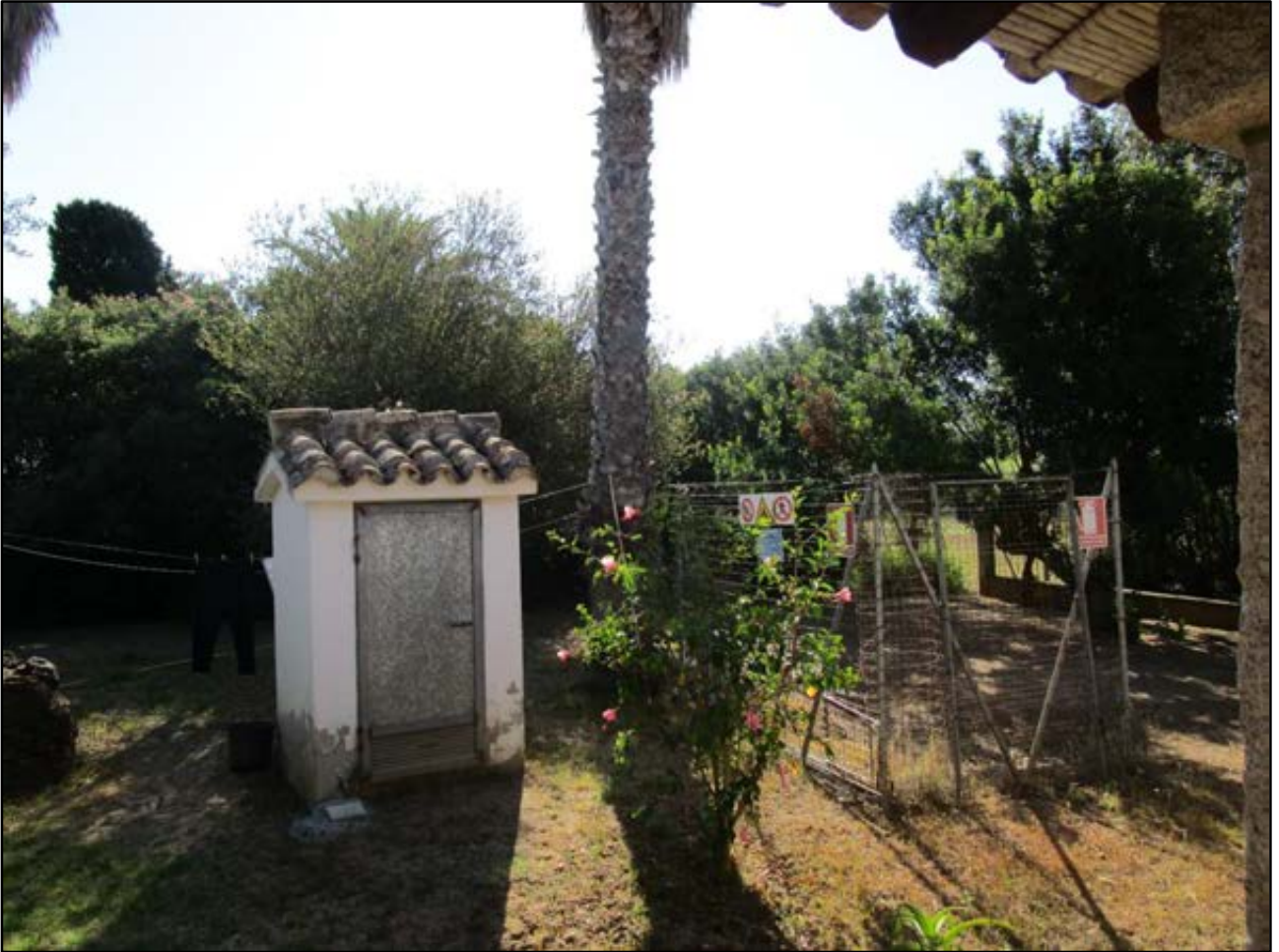
Foto 31: locale tecnico e deposito GPL interrato
