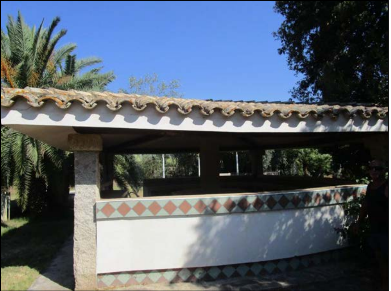
Foto 42: edificio adibito a bar presente in giardino
