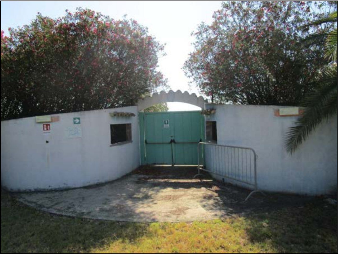
Foto 47: uscita di sicurezza
