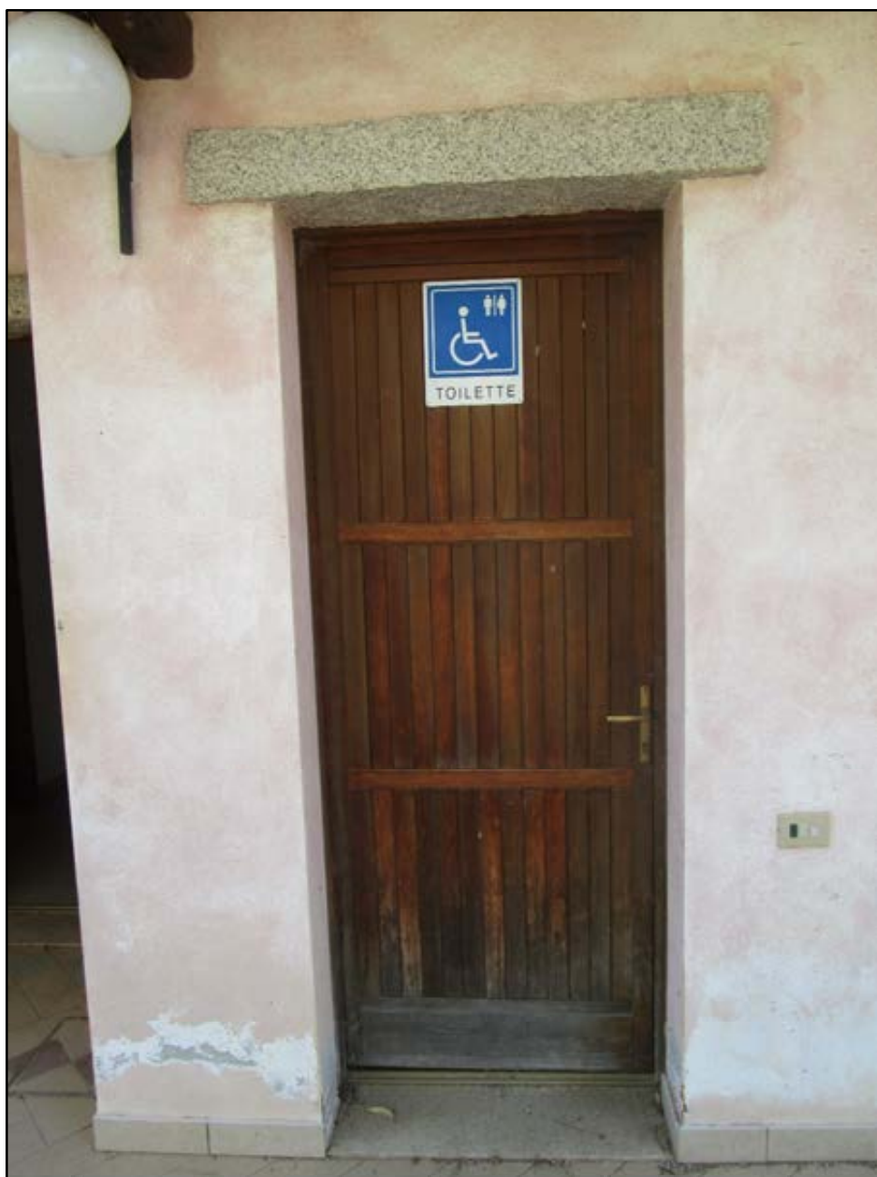
Foto 15: ingresso di uno dei bagno esterni per la clientela della discoteca all'aperto
