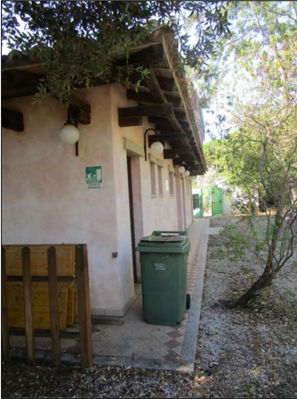
Foto 14: ingressi del bagno esterni per la clientela della discoteca all'aperto
