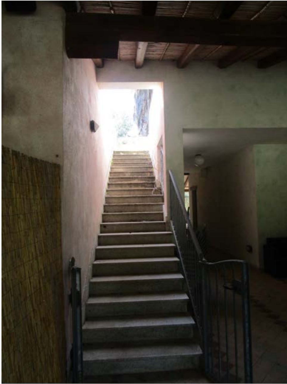
Foto 19: scala di accesso alla terrazza sovrastante la sala principale
