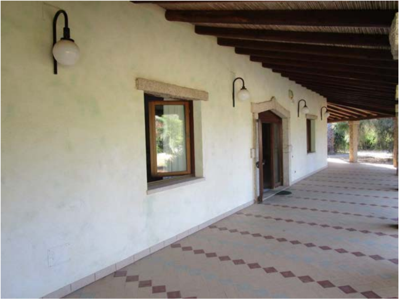
Foto 3: accesso al locale principale (sala ristorante) dal patio
