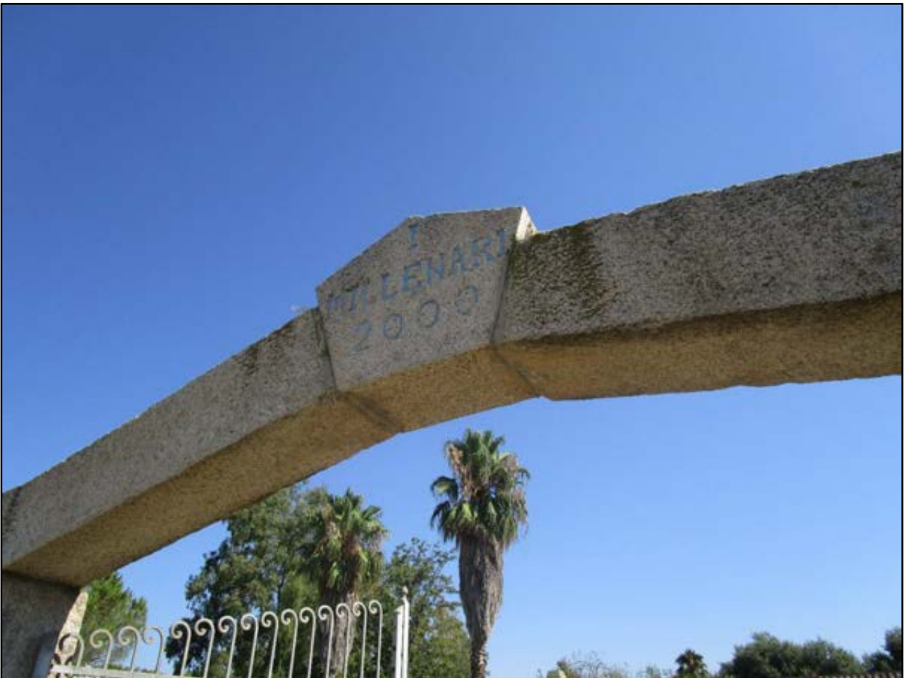
Foto 1 e 1A: ingresso principale e particolare
