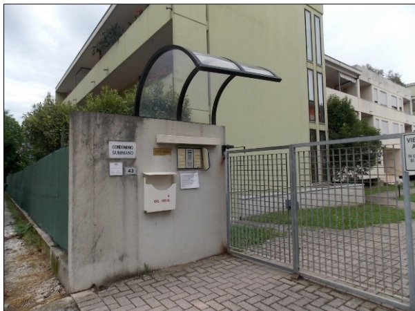
Ingresso da via S. Vincenzo n° 43
