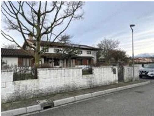
Prospetto su via Volta
