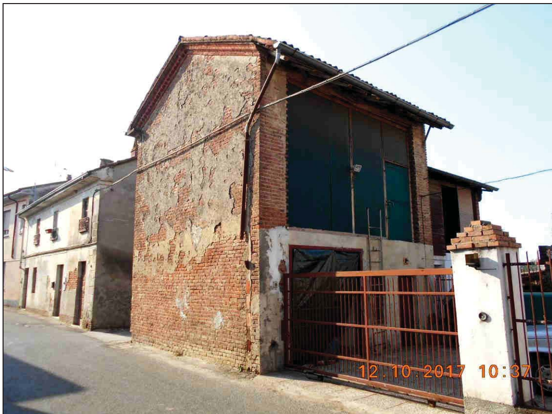
Figura 6 – vista esterna dei due fronti del fabbricato rustico dalla pubblica via
