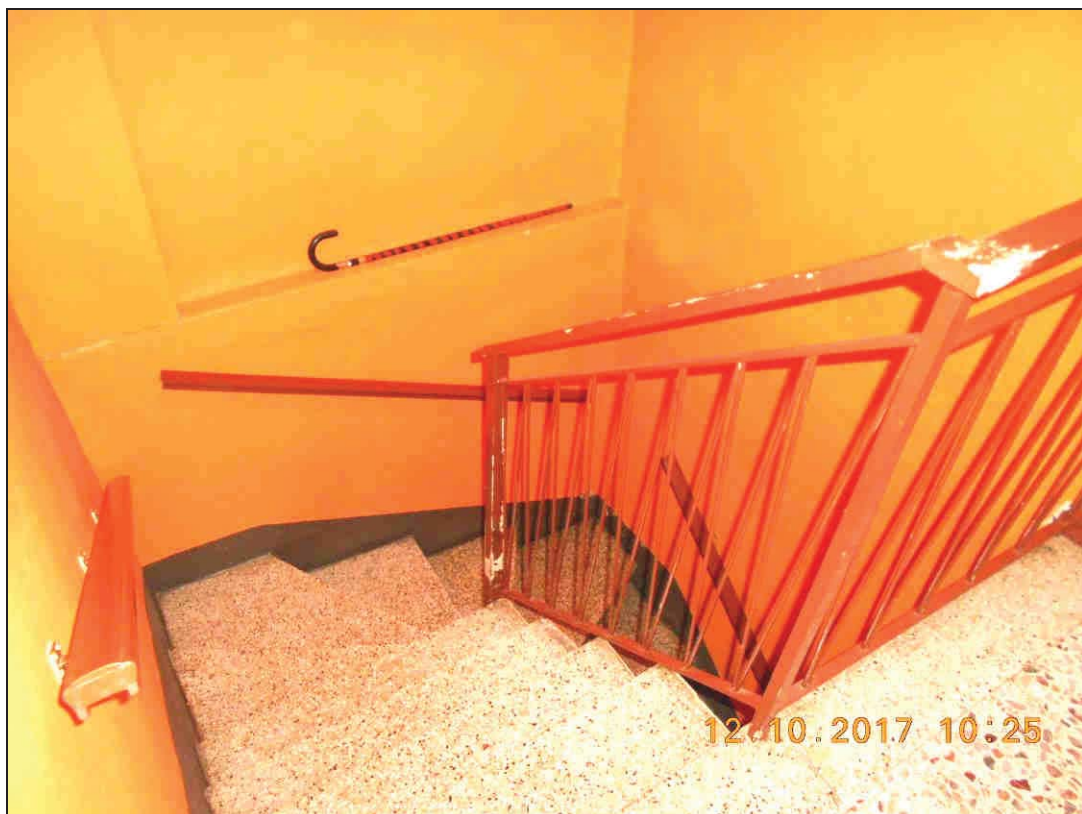
Figura 16 – vista interna del vano scala per il collegamento tra i due piani
