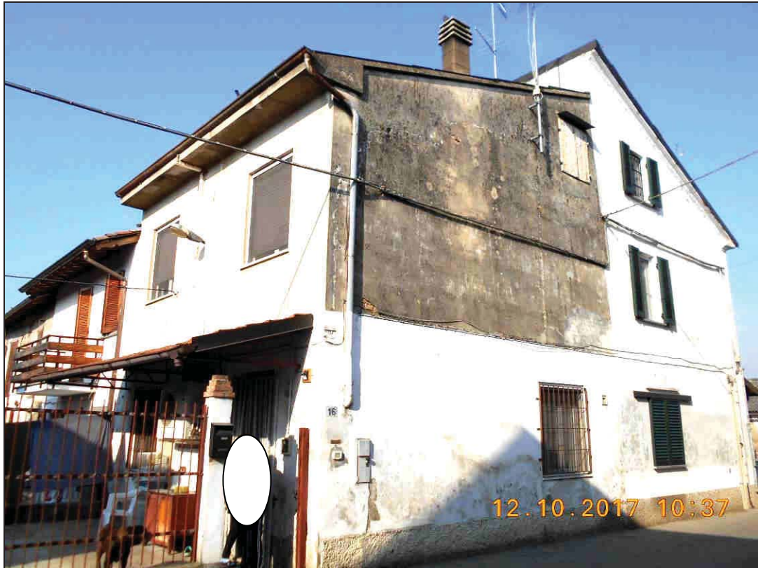
Figura 3 – vista esterna dei due fronti dell'abitazione dalla pubblica via
