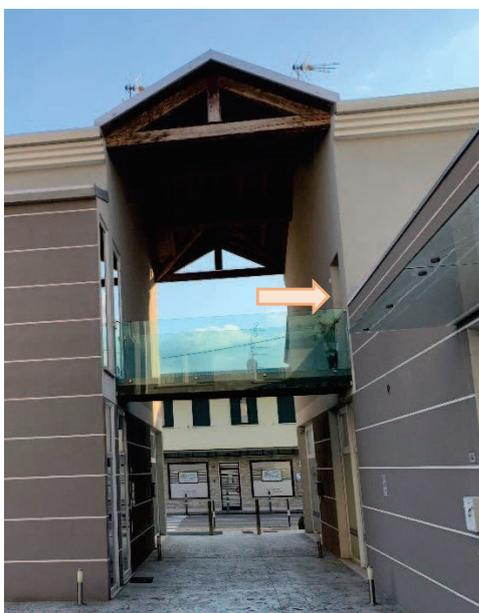
da tre piani fuori terra e un piano sottotetto; nella parte sud del lotto parallelamente al primo blocco, è presente una seconda "ala" realizzata parallelamente a Via Vittorio Emanuele III, costituita da due blocchi rettangolari uniti dalla copertura e separati da una galleria passante a tutta altezza che permette il collegamento tra il marciapiede lungo la strada e la corte interna al complesso condominiale.
