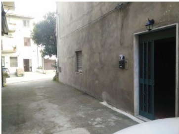
INGRESSO CORPO SCALA LATO EST
