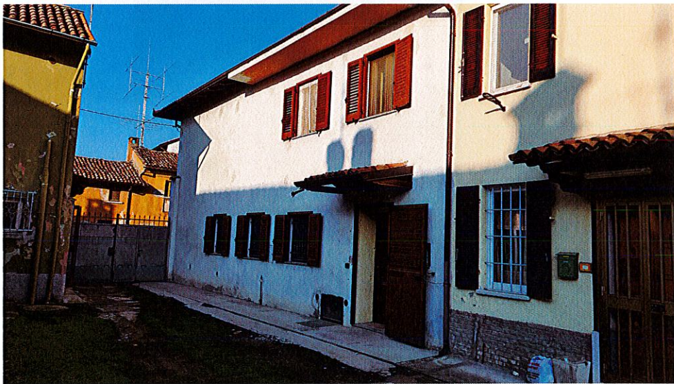
Prospetto dal cortile comune
