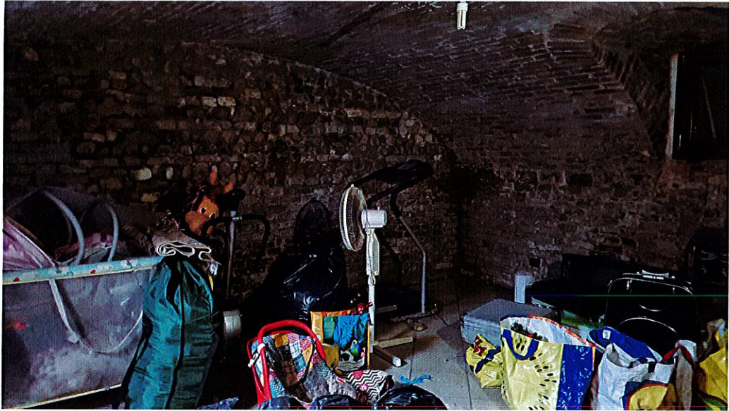
Abitazione – cantina-tavernetta a piano interrato
