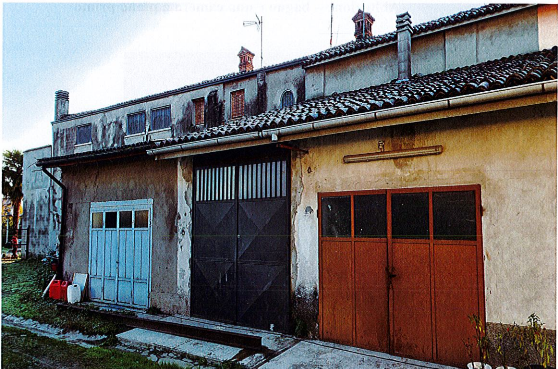
Autorimessa – prospetto verso il cortile comune
