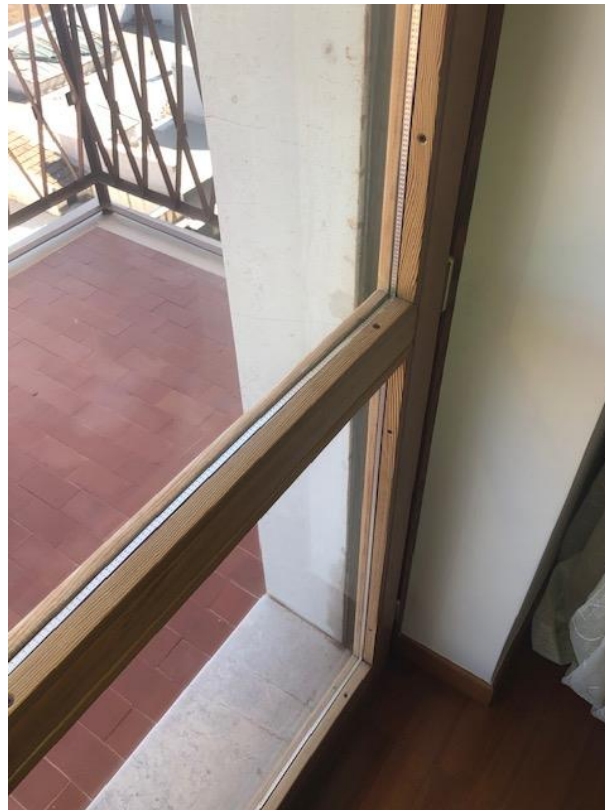
Dettaglio del serramento esterno
