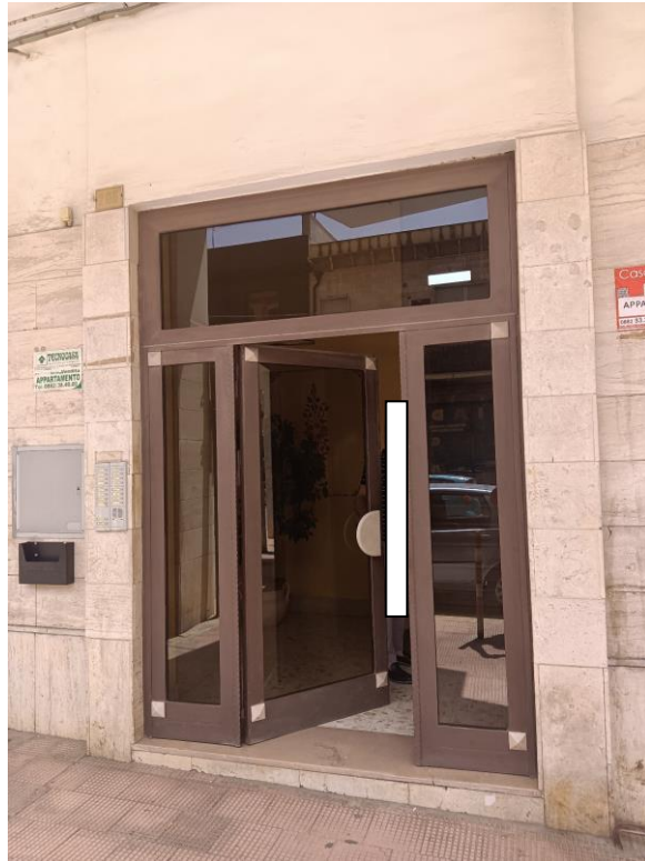
Particolare del portone di ingresso della palazzina
