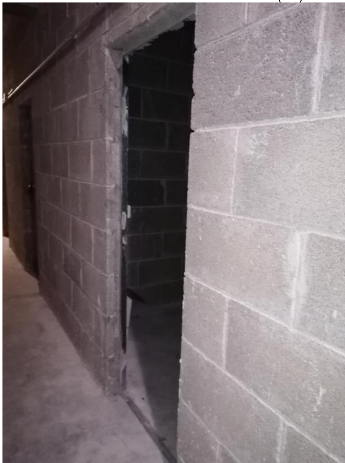
FOTO N°12: Vista esterna della cantina (2/2).
