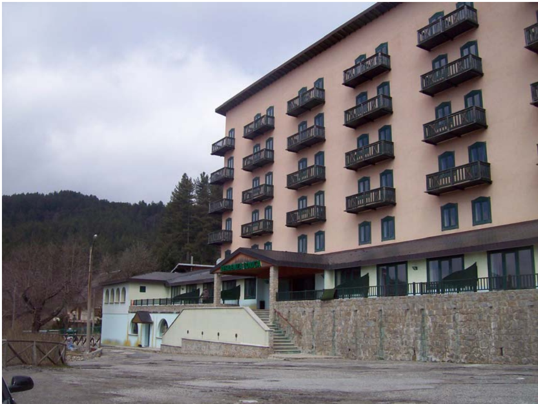
Foto 1 – Ingresso alla struttura
