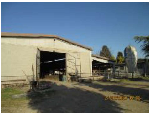
Foto 12- esterni immobile A4 Stalla
