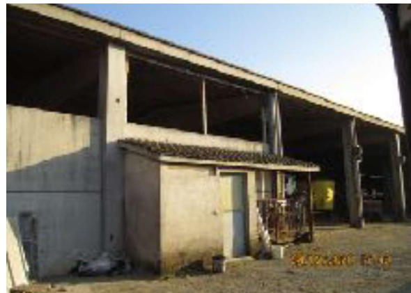
Foto 14- esterni Deposito tettoia
