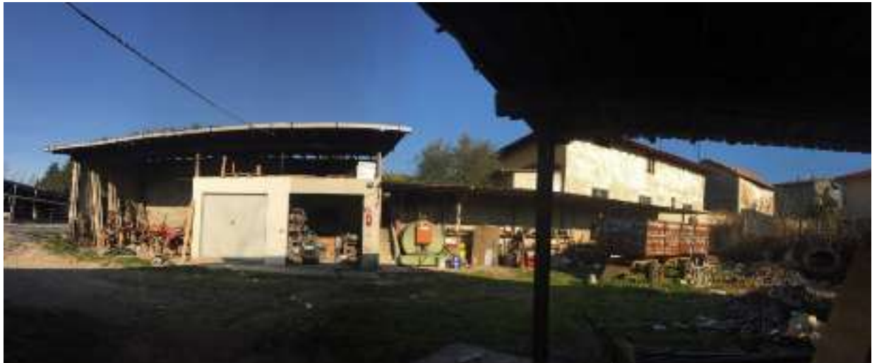
Foto 8 - esterni immobile A1 tettoie-depositi
