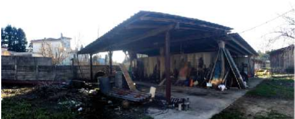
Foto 9- esterni immobile A2 tettoie-depositi
