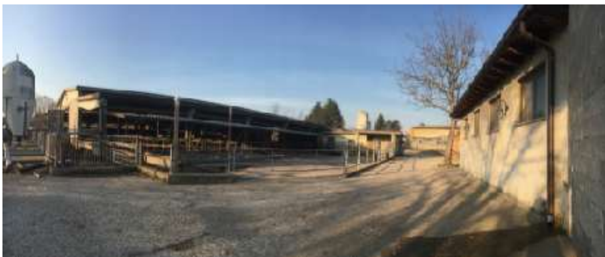
Foto 12- esterni immobile A4 Stalla area Paddock
