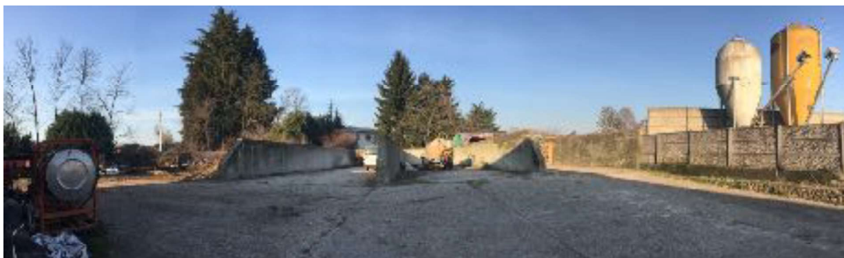
Foto 15- esterni Silos orizzontali aperti
