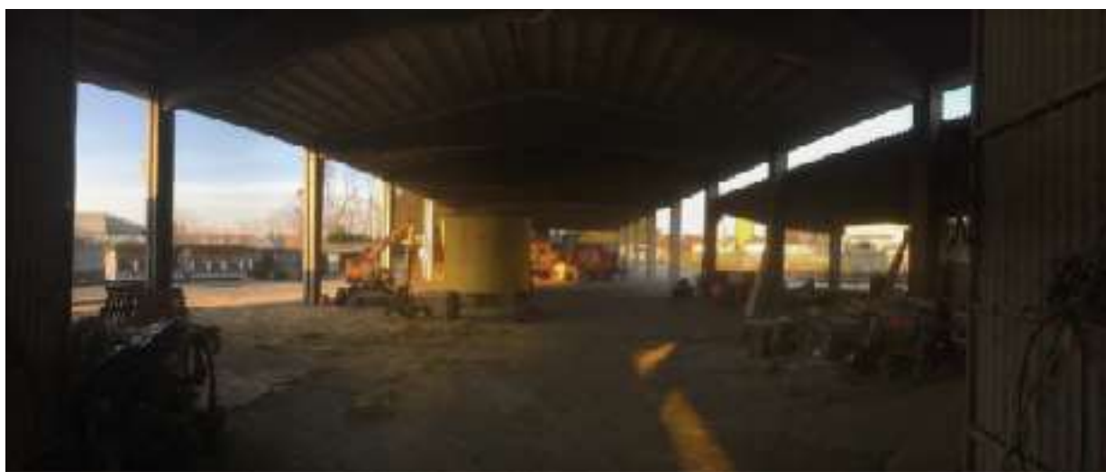
Foto 13 - interni immobile A4 Fienile
