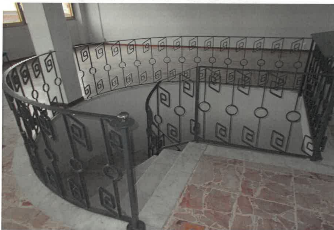
10. Particolare interno – vano scala interno
