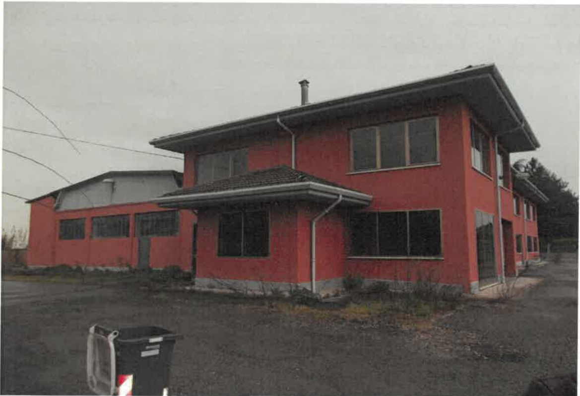
2. Particolare lato sud
