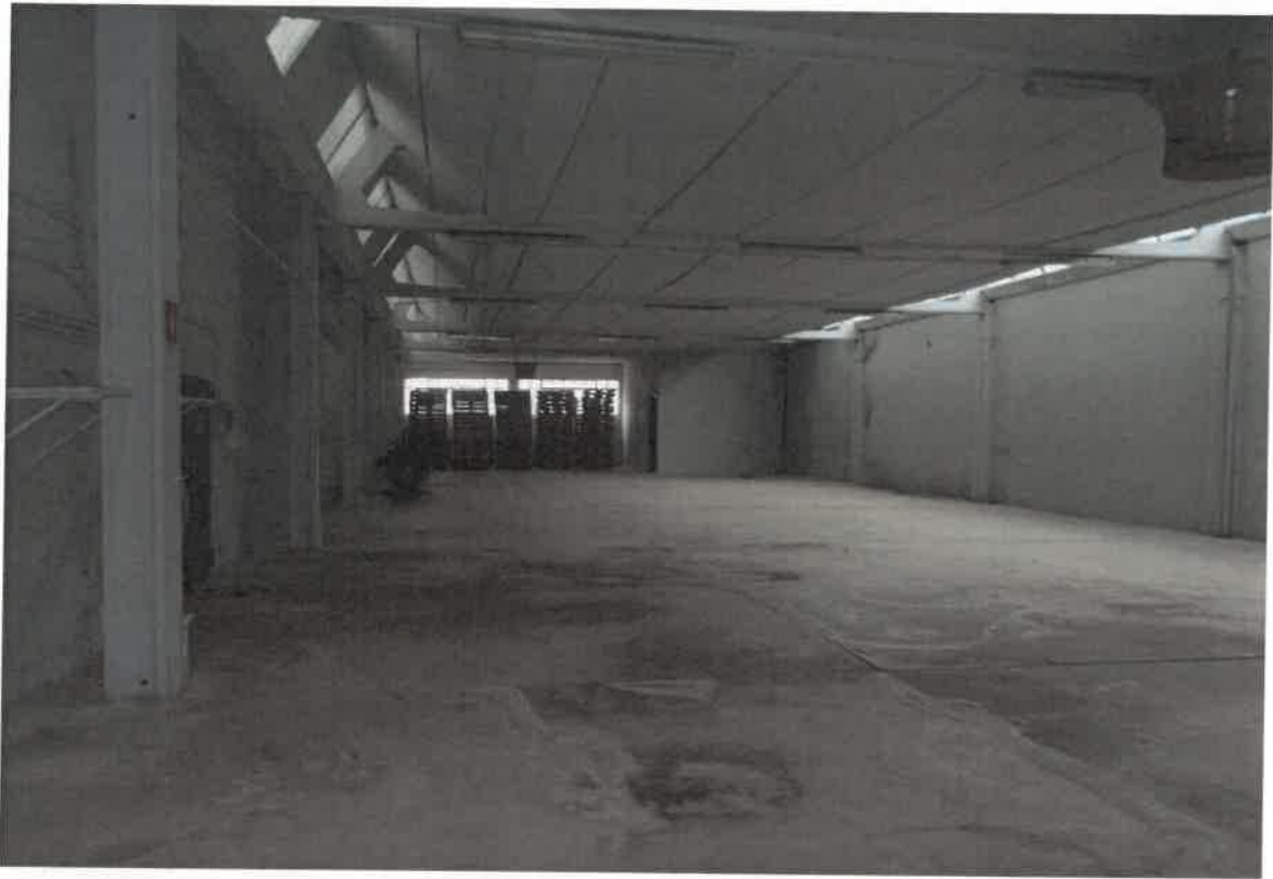
5. Particolare interno – laboratorio al piano terra
