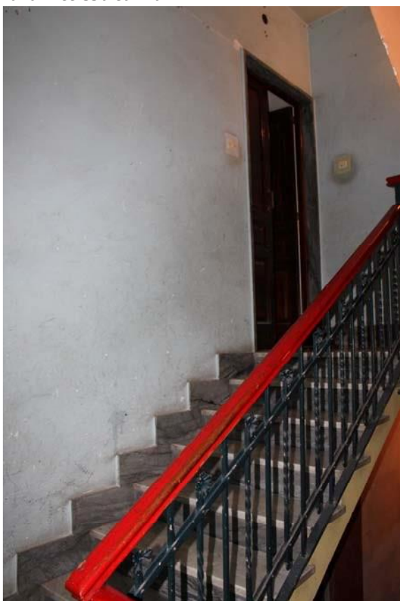
FOTO – VANO SCALA CONDOMINIALE
