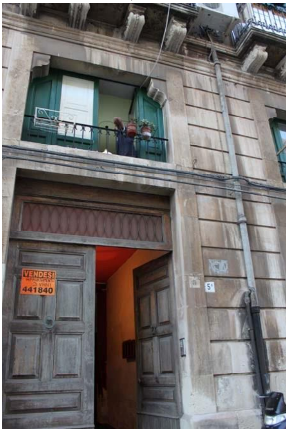
FOTO - ACCESSO CONDOMINIALE
