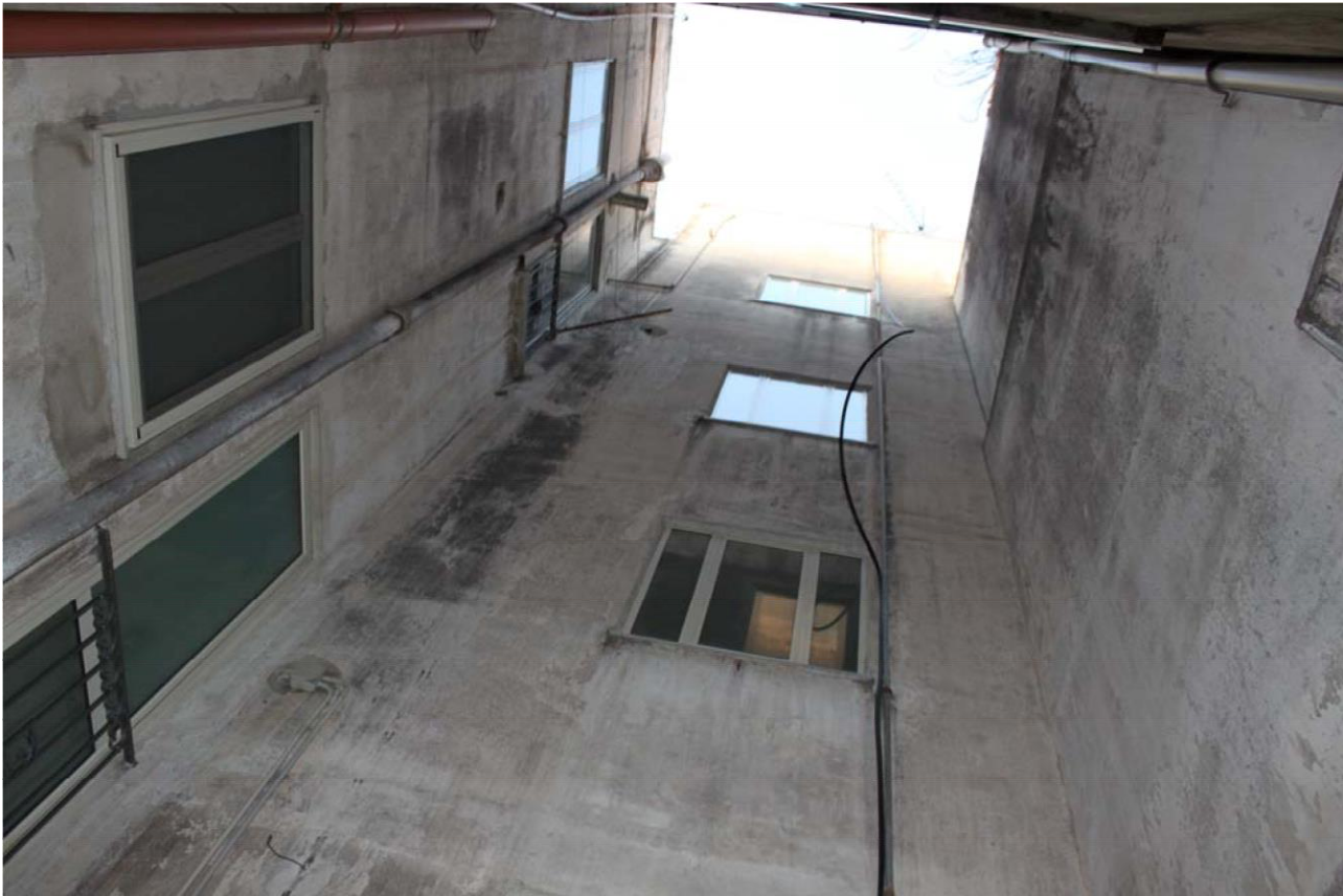
FOTO – CORTILE INTERNO CONDOMINIALE
