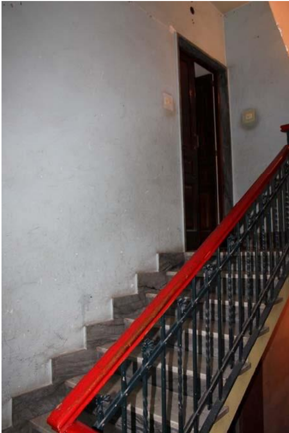
FOTO - VANO SCALA CONDOMINIALE
