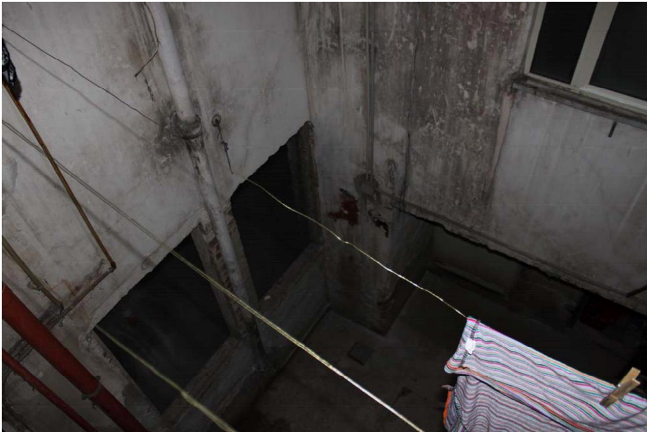
FOTO – CORTILE INTERNO CONDOMINIALE
