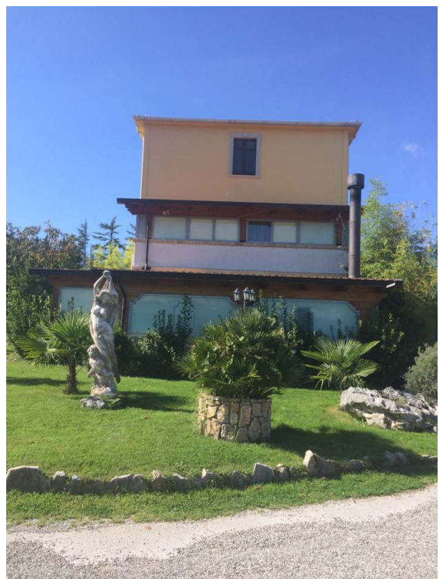
foto 40 – vista sud fabbricato adibito ad albergo
