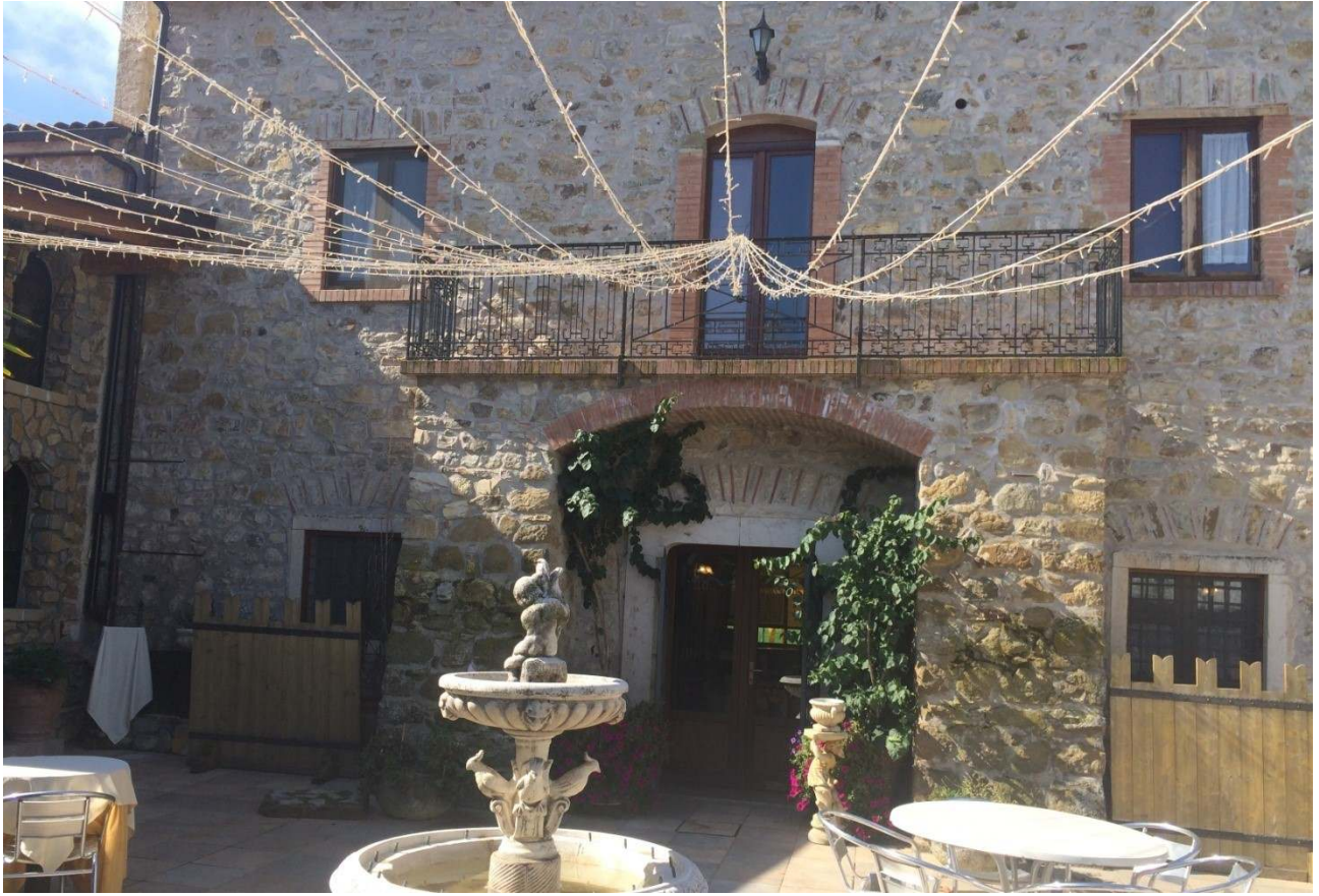
foto 23 - prospetto est fabbricato in pietra
