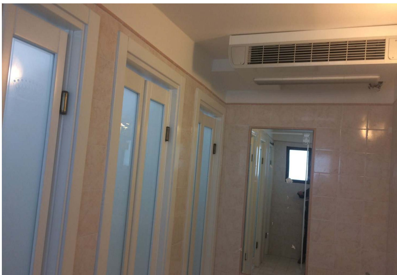
foto 28 - w.c. piano seminterrato
