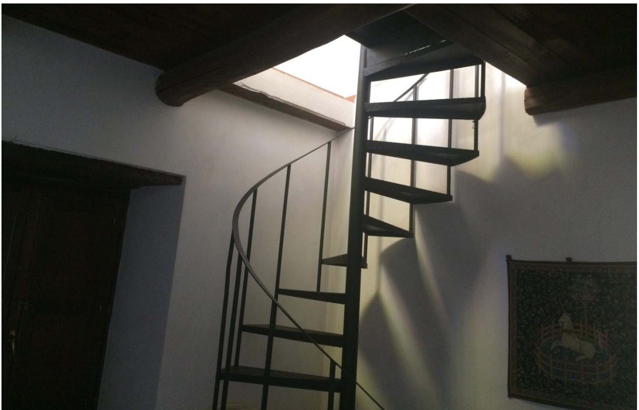
foto 33 - scala di accesso al sottotetto con camere
