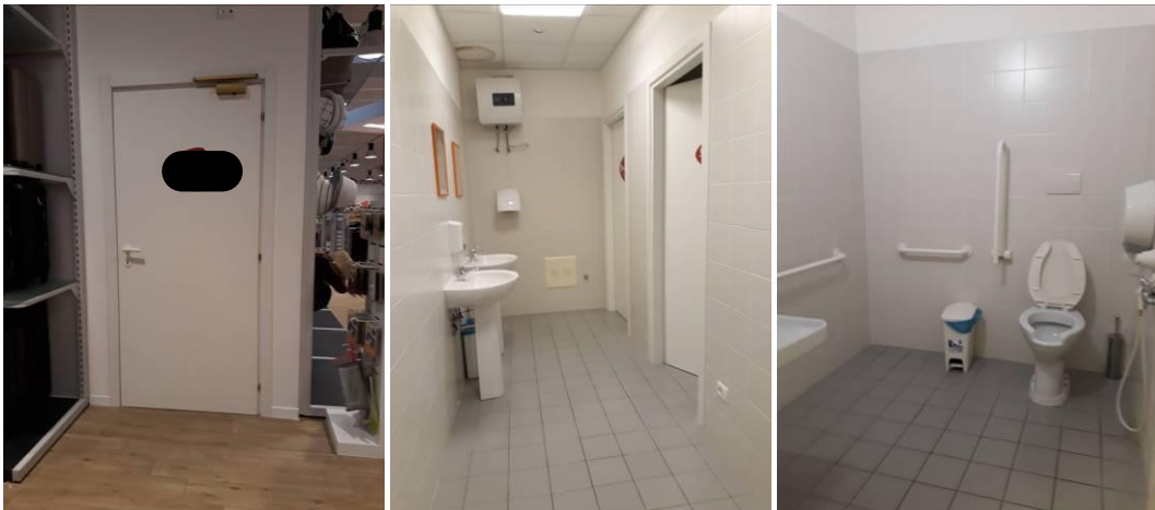
Sub ..... Pittarosso: Livello terra – Interni negozio / Particolari infissi, soffitti e pavimenti / servizi igienici
