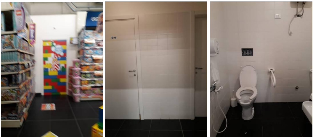
Sub ..... Toys: Livello terra – Interni negozio / Particolari infissi, soffitti e pavimenti / servizi igienici
