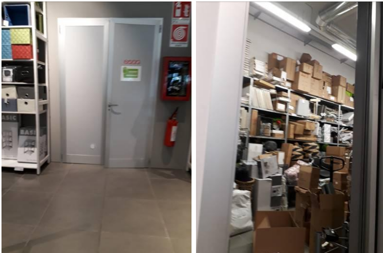
Sub ..... Casa: Livello terra – Interni negozio / Particolari infissi, soffitti e pavimenti / magazzino
