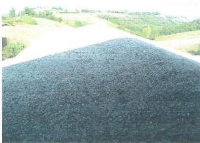
**Figura 13 vista copertura: si nota la mancanza del manto di copertura**
