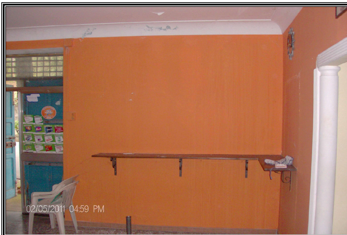
FOTOGRAFIA n. 6 - Vista dall'interno “Locale Commerciale”
