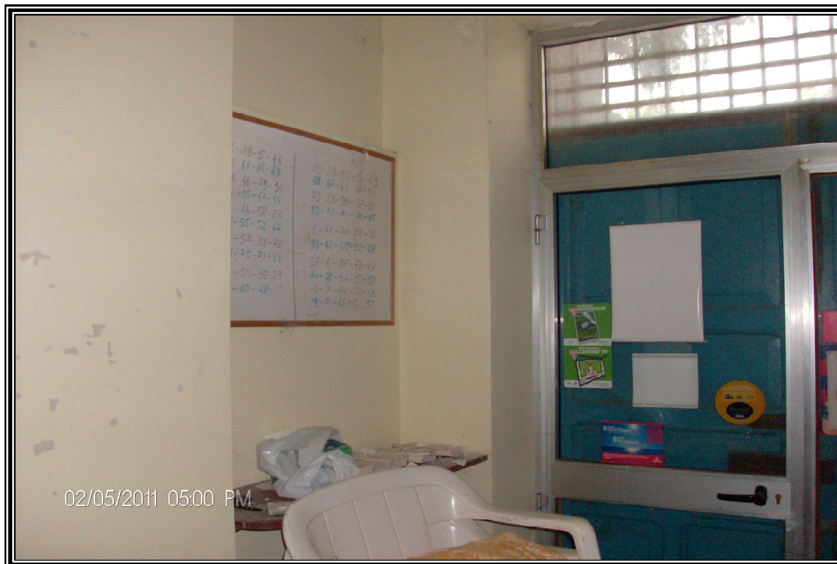
FOTOGRAFIA n. 5 – Vista dall'interno “Locale Commerciale”
