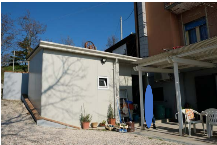
foto n.93 – veduta esterna del ripostiglio censito come b.c.n.c ai sub.7 e 11, oggetto della prenesse procedura
