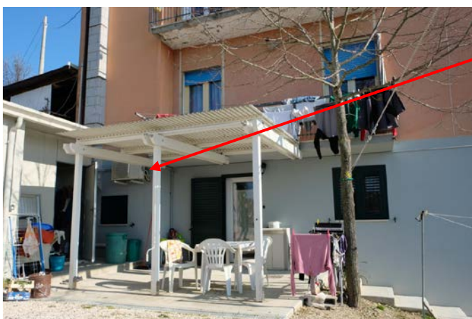
foto n.113 – veduta del corpo esterno dell'impianto di raffrescaemnto degli ambienti adibiti ad appartamento ricavati, senza titolo autorizzativo, nell' autorimessa
