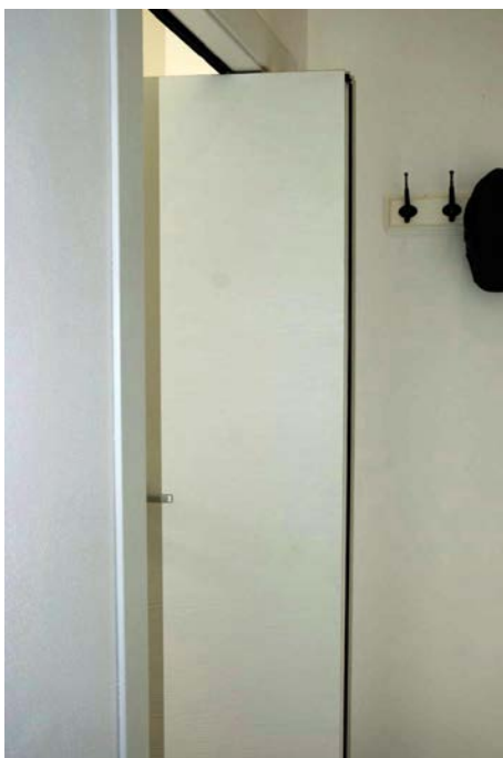
foto n.47 – veduta della porta di accesso al secondo bagno, dal disimpegno
