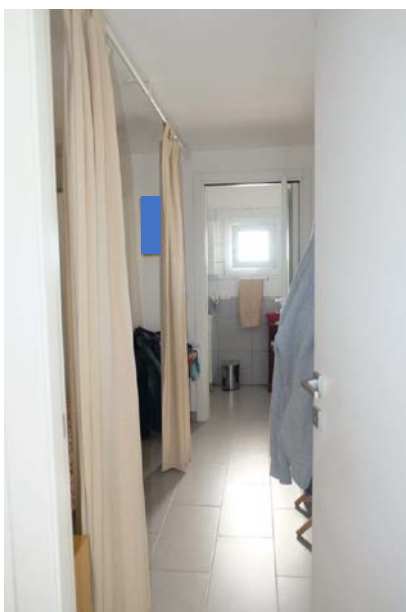
foto n.84– veduta dell'autorimessa utilizzata, impropriamente, come appartamento
