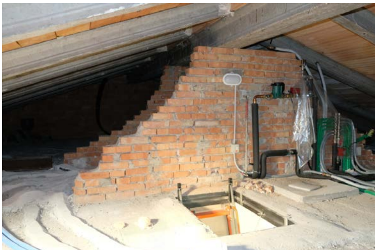
foto n.70 – veduta del sottotetto
