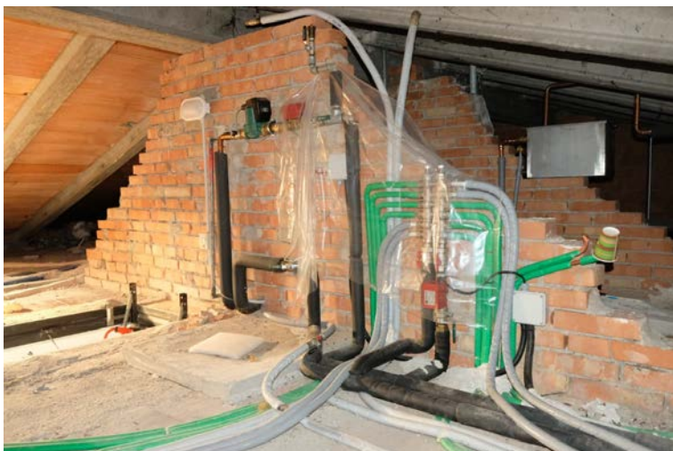
foto n.72 – veduta del sottotetto
