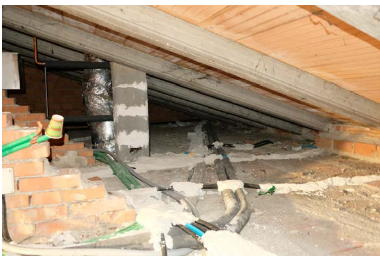
foto n.71 – veduta del sottotetto
