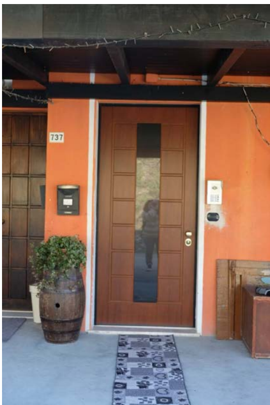
foto n.21 – particolare della porta di accesso alla porzione di fabbricato ove sono ubicate le u.i. oggetto di procedura
