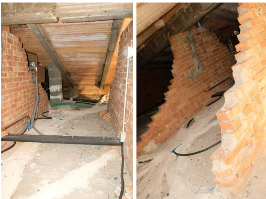
foto n.73-74 – veduta del sottotetto
