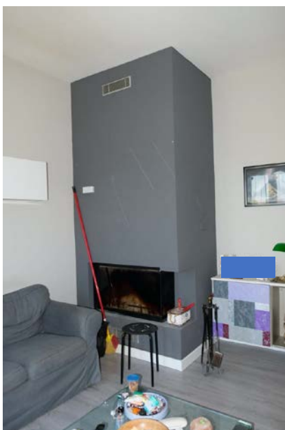
foto n.55-56 – veduta del camino realizzato nel soggiorno e delle “bocche” di uscita dell’aria calda prodotta
