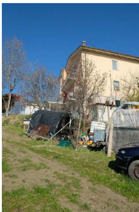
foto n.8 - veduta di parte dell'intero fabbricato in cui sono ubicate le u.i. oggetto di procedura (retro e fianco lato particella 139)
