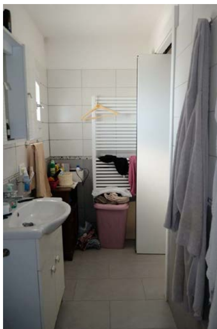
foto n.109-110 – particolari delle tipologie dei corpi scaldanti presenti negli ambienti adibiti ad appartamento ricavati, senza titolo autorizzativo, nell' autorimessa
