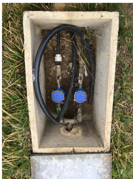
foto n.122-123 – veduta del pozzetto e dei contatori dell'acqua
