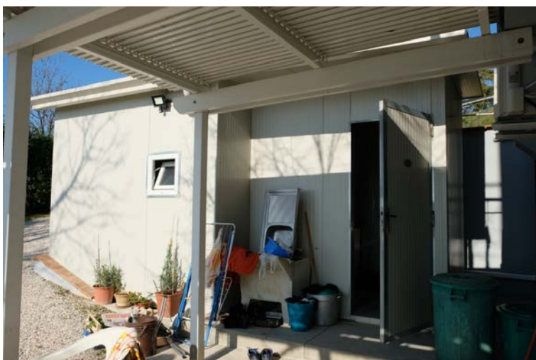
foto n.94 – veduta esterna del ripostiglio censito come b.c.n.c ai sub.7 e 11, oggetto della prenesse procedura
