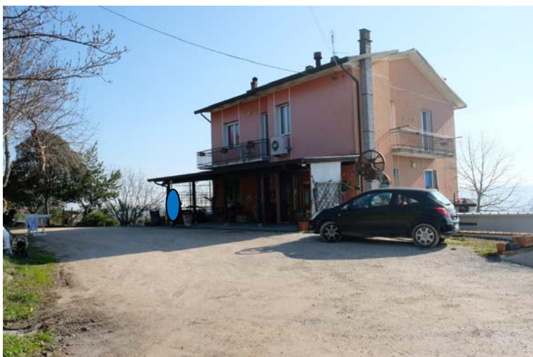
foto n.18 - veduta del fabbricato ove sono ubicate le u.i. oggetto di procedura e di parte della corte comune a tutte le unità insistenti sulla particella 138, identificata con il sub.10.
