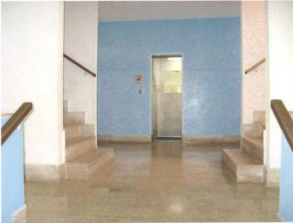
ATRIO INGRESSO - VIA ALDO MORRO N. 25 ASCENSORE E SCALE
