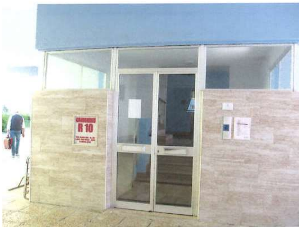
EDIFICIO IN VIA ALDO MORO N. 25 – INGRESSO COMDOMINIO R10
