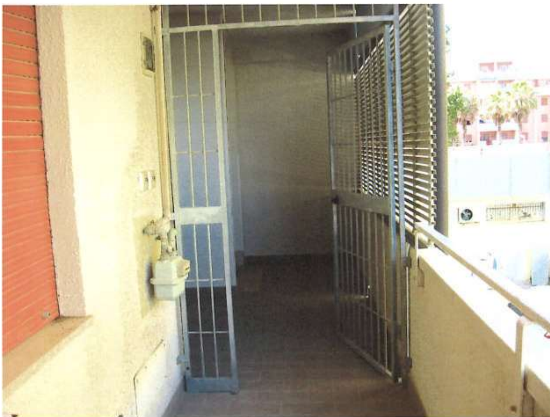
ACCESSO APPARTAMENTO PIANO PRIMO – BALCONE LATO SUD
