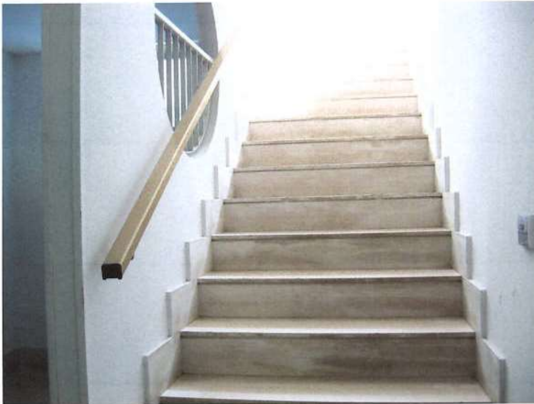
SCALA INTERNA ACCESSO AL PIANO PRIMO VIA ALDO MORO N.25
