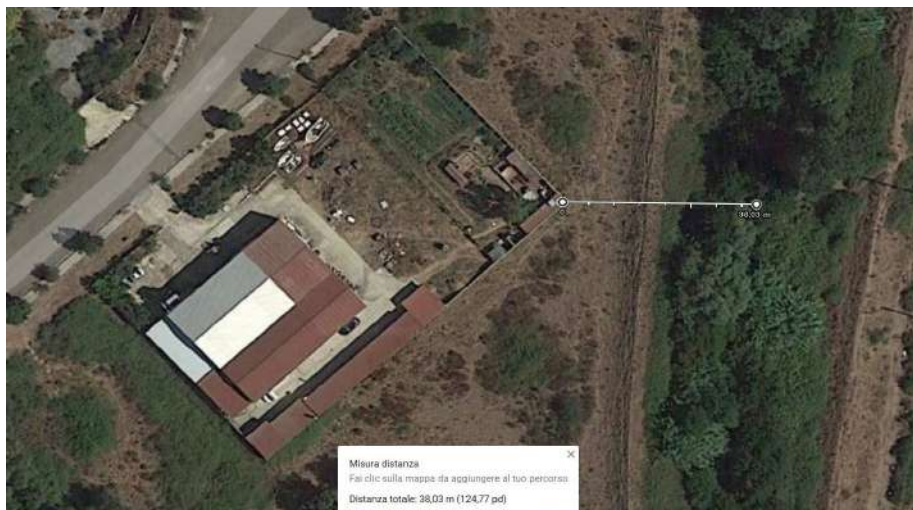
4. Lotto 2 distanza fabbricati dal Rio Siniscola _ 38 ml ca.
