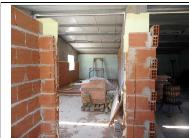
17. Locali piano primo
