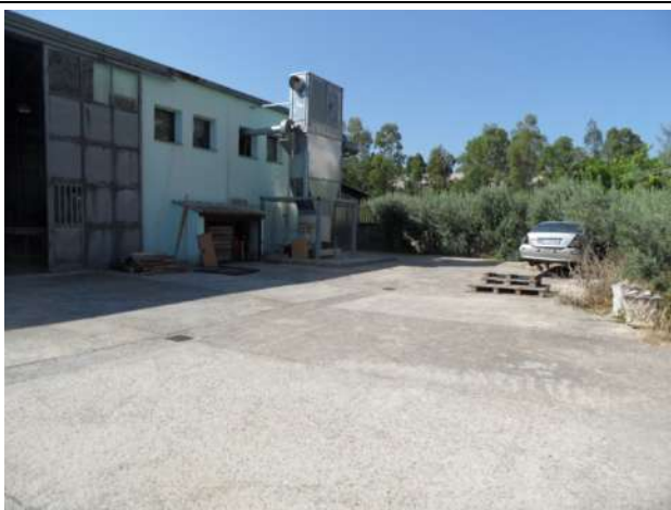
9. Vista piazzale di manovra
