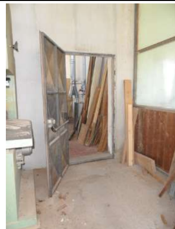
24. Laboratorio lato veranda S-O
