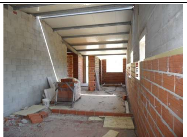
18. Locali piano primo
