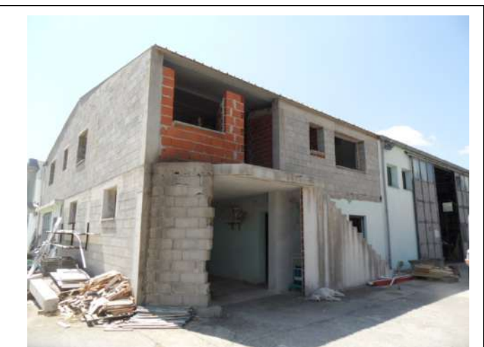
6. Parte in sopraelevazione prospetto principale
