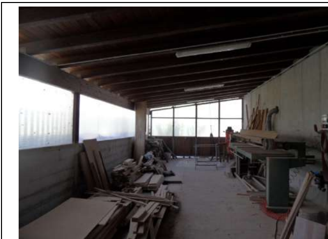
15. Veranda coperta lato S-O
