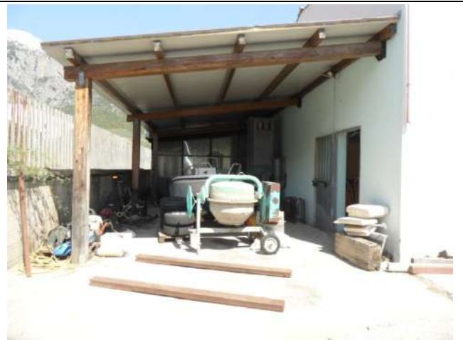
14. Tettoia lato S contigua alla veranda coperta
