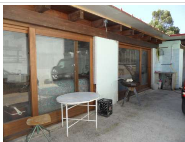
12. Locali cucine lato S-E di confine
