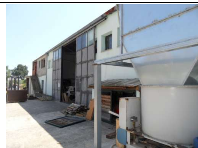
5. Capannone falegnameria, ingresso principale
