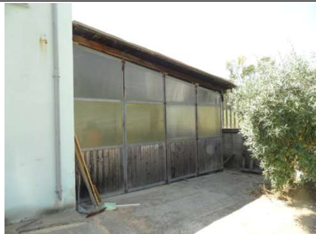
10. Vista veranda chiusa lato ovest
