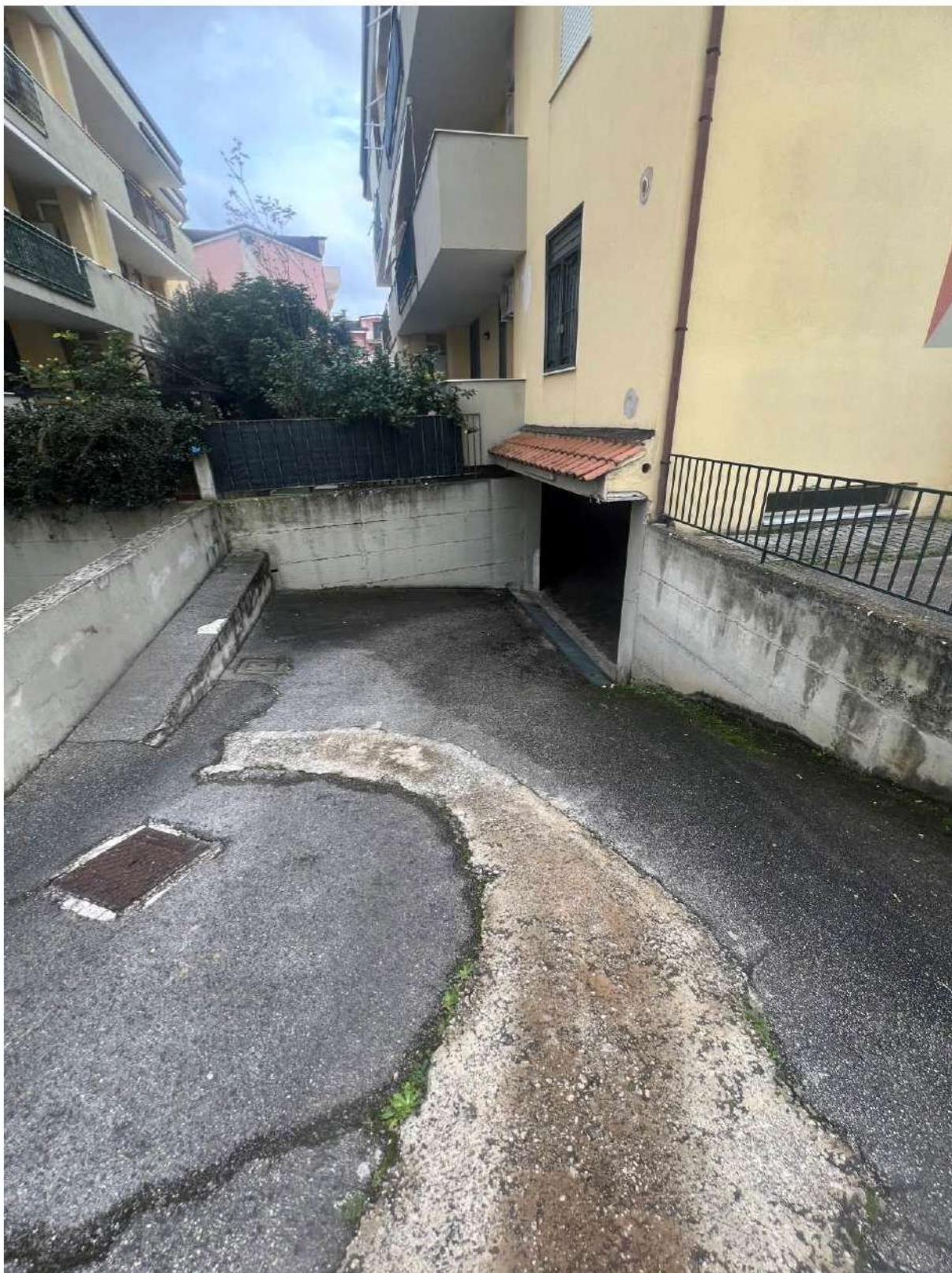
Foto viale di accesso al piano S1
