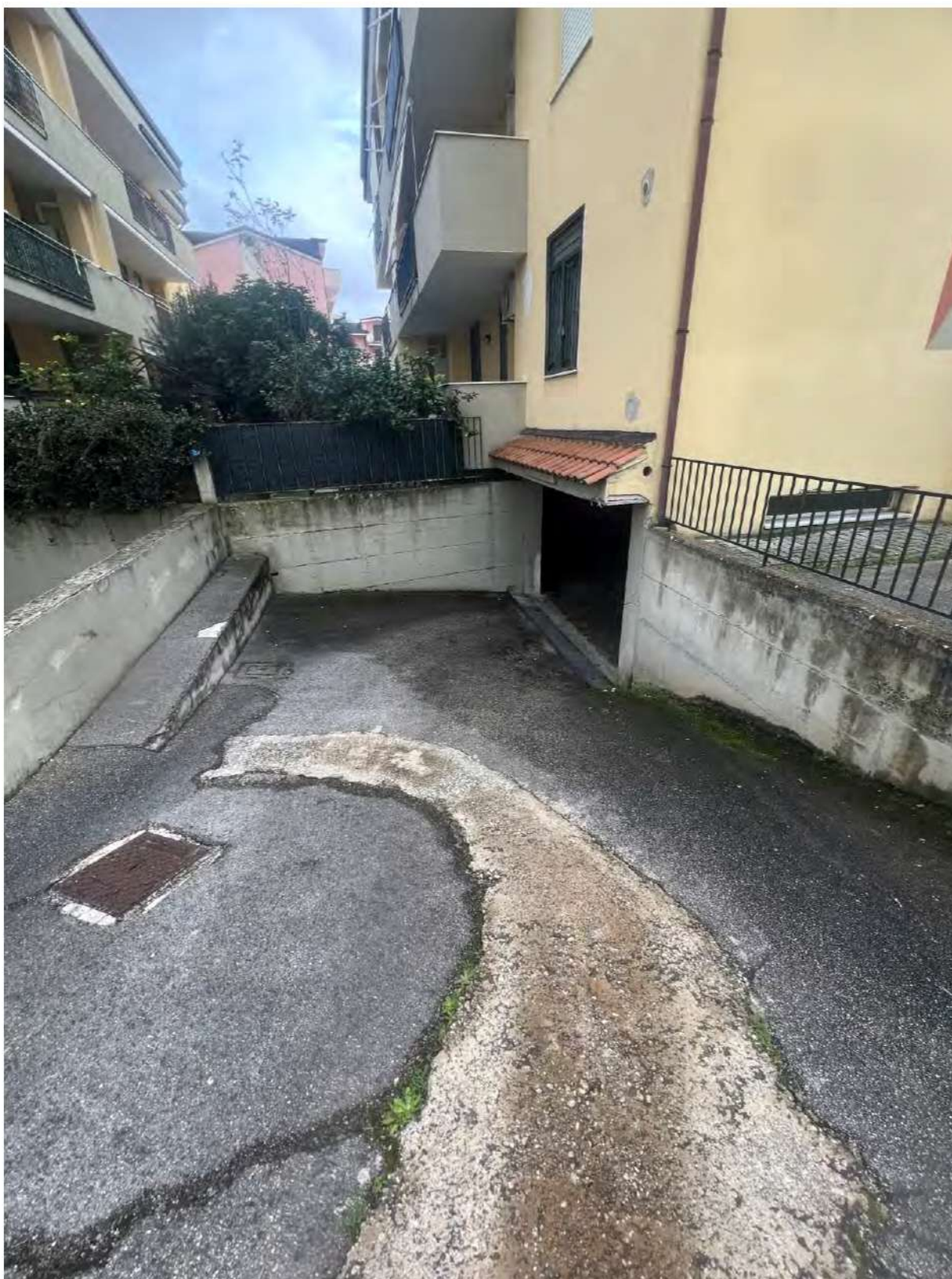
Foto viale di accesso al piano S1
