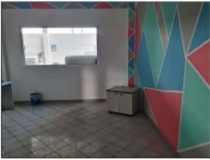
FOTO 37 - Uffici piano terra
