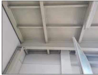
FOTO 26 - Struttura soppalco
