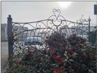
FOTO 16 - Recinzione in ferro
