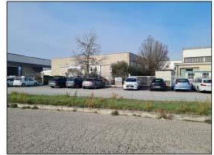
FOTO 03 - Vista del capannone
