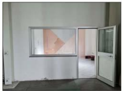
FOTO 42 - Uffici piano terra
