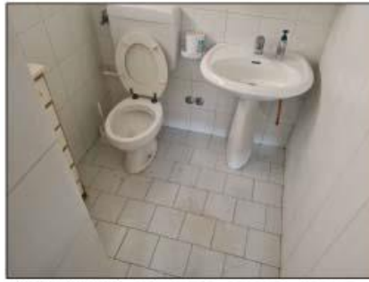
FOTO 38 - Bagno piano terra
