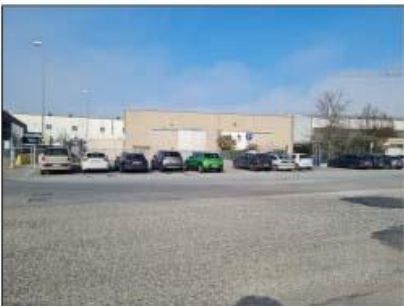
FOTO 04 - Vista del capannone
