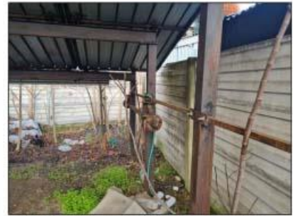
FOTO 15 - Tettoia in confine
