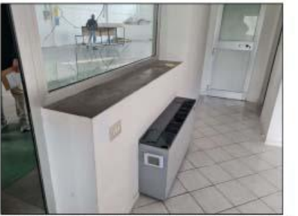
FOTO 48 - Ventilconvettori uffici
