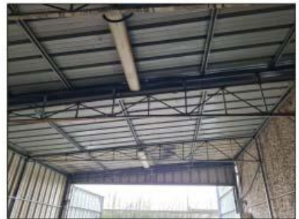
FOTO 33 - Copertura tettoia retro
