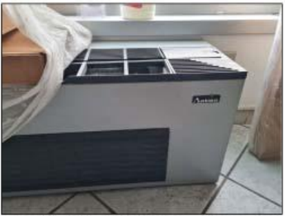
FOTO 46 - Ventilconvettori uffici
