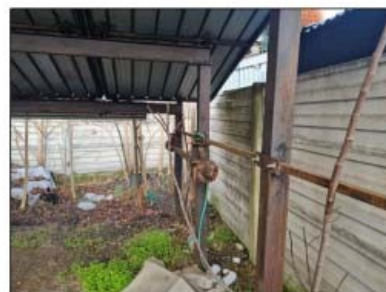
FOTO 15 - Tettoia in confine
