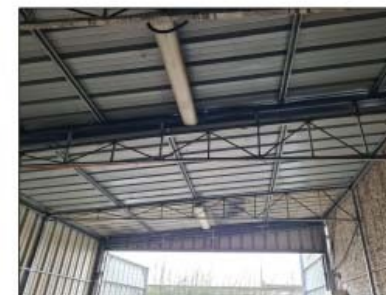
FOTO 33 - Copertura tettoia retro
