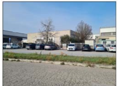
FOTO 03 - Vista del capannone
