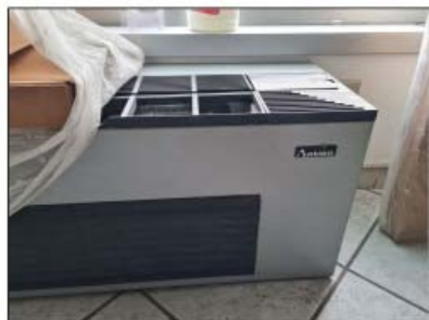
FOTO 46 - Ventilconvettori uffici
