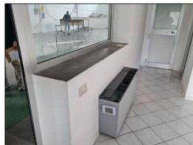
FOTO 48 - Ventilconvettori uffici
