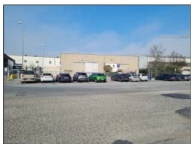
FOTO 04 - Vista del capannone
