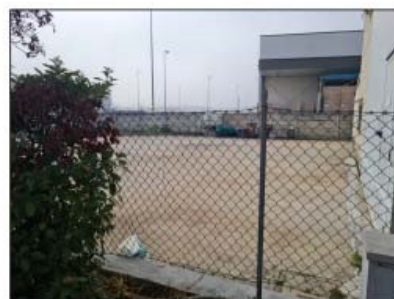
FOTO 18 - Recinzione in rete
