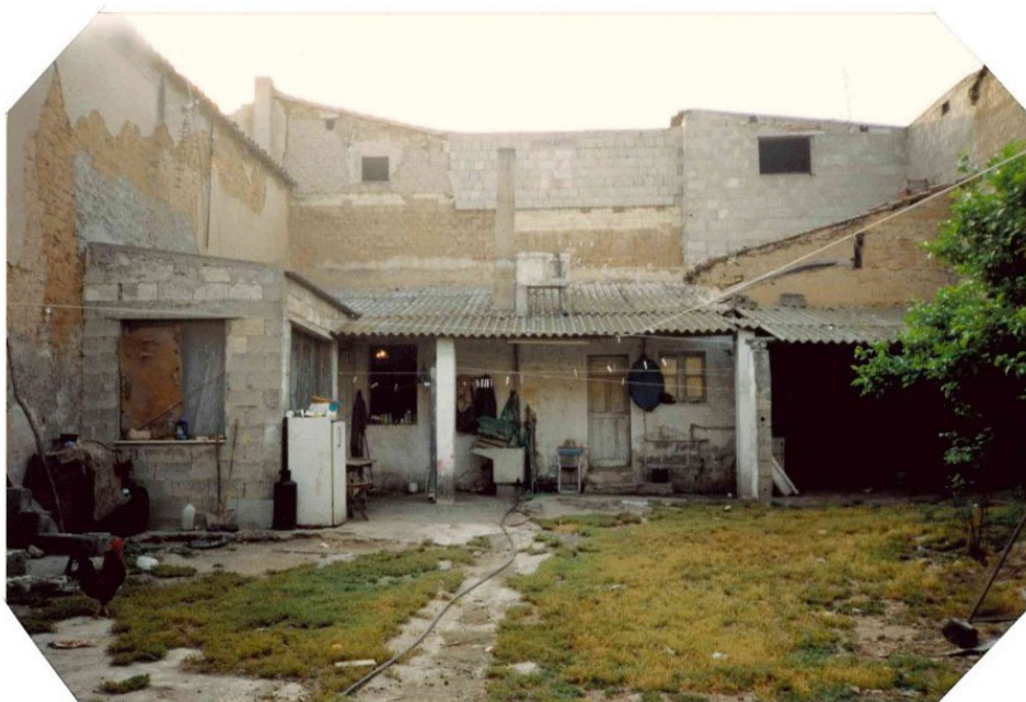
2 - Cortile interno – superfetazioni
