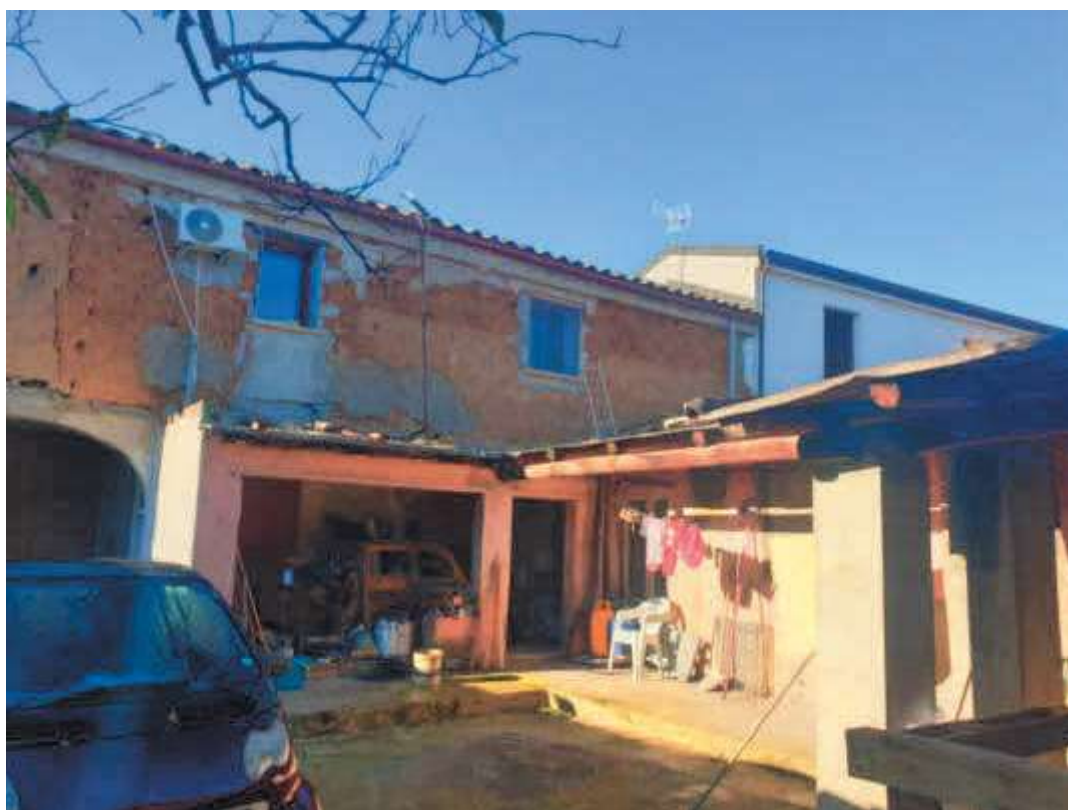
10 – VISTA CORTILE LATO IMMOBILE
