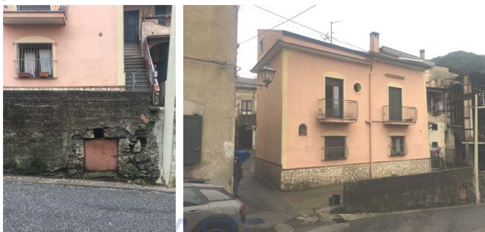
Vista del fabbricato dalla strada provinciale
