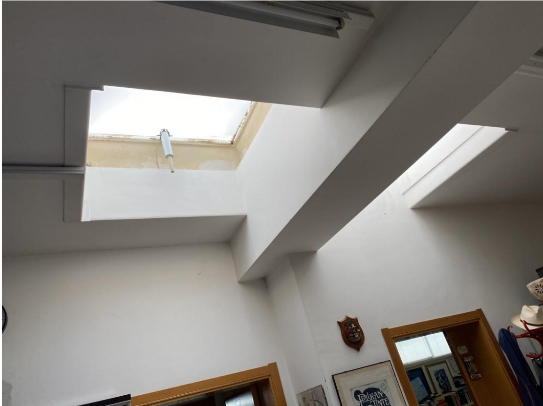
Foto 13 – Dettaglio Interno: Lucernari
