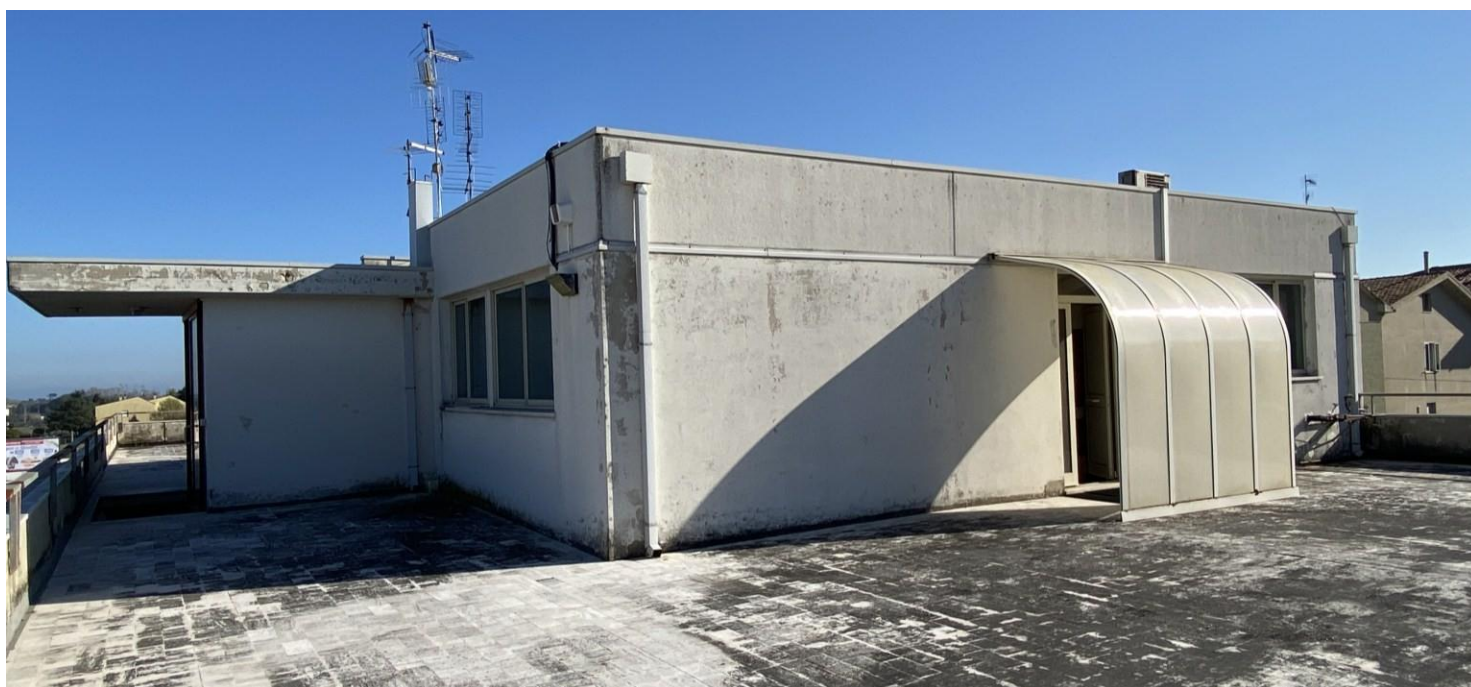
Foto 6 - Veduta Generale Nord, ingresso appartamento.
