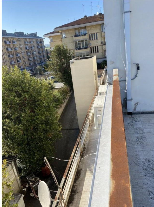
Foto 3 Veduta dell'affaccio Ovest.
