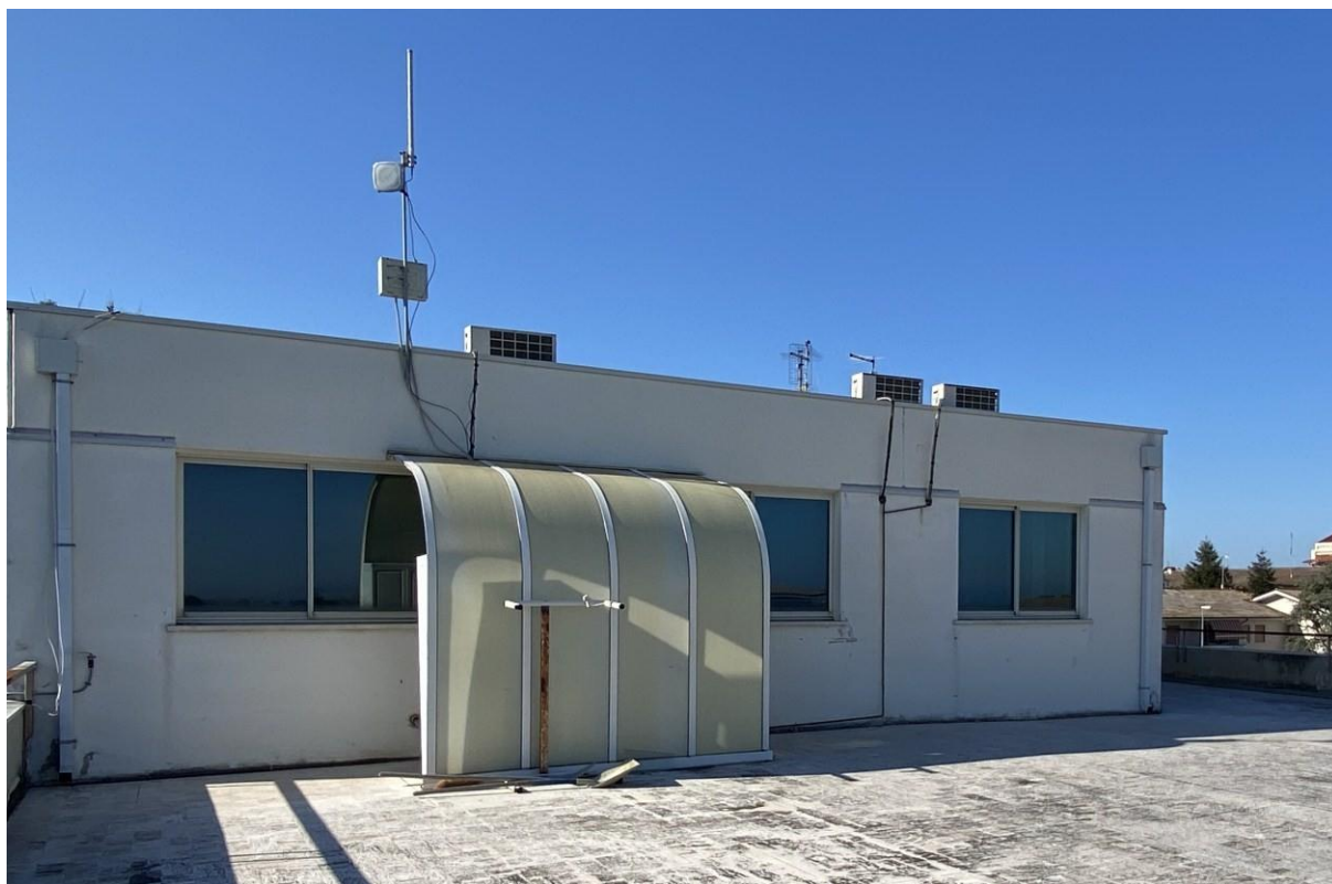
Foto 1 - Veduta del lato Sud – Est.
