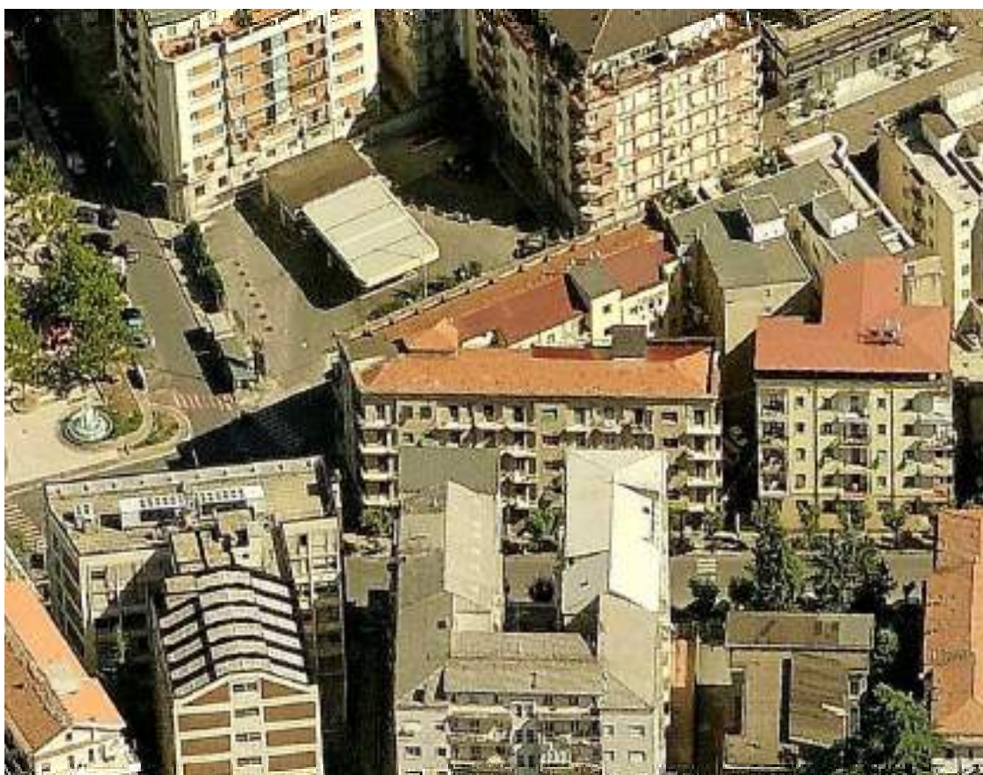
Veduta aerea da occidente del fabbricato
