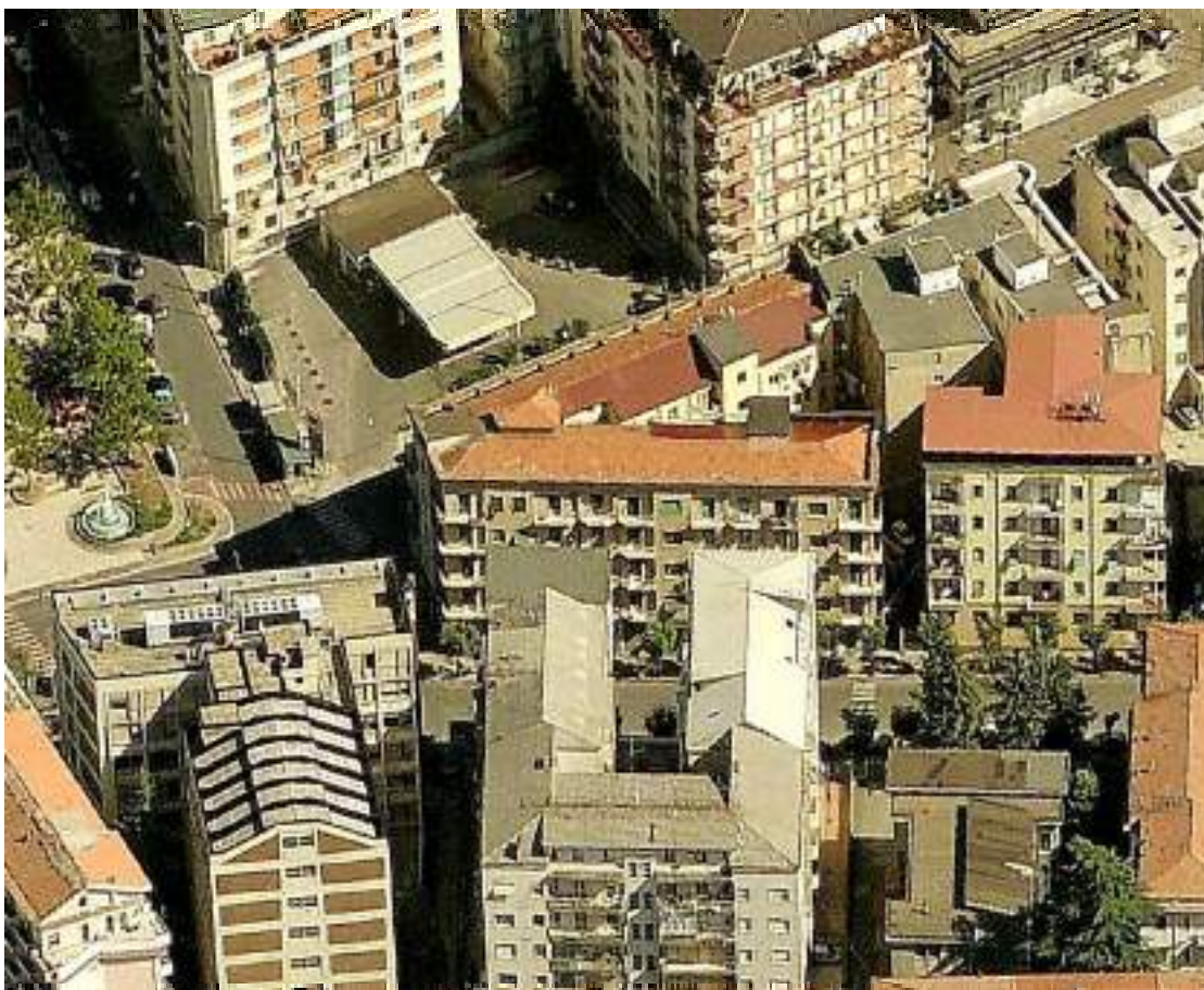
Veduta aerea da occidente del fabbricato
