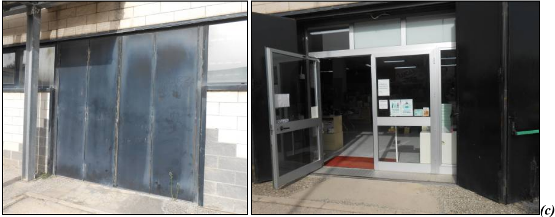
Figura n° 9. Fotografie della porzione di corte su cui costituire la servitù di passaggio: area esterna da asservire (a); cancelli di accesso alla corte con servitù (b); ingressi al pianterreno del cespite staggito (c).
