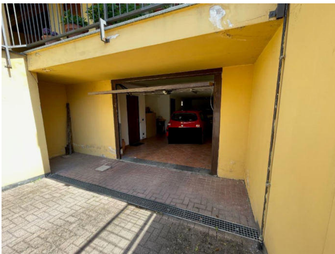
Entrata Locale Autorimessa
