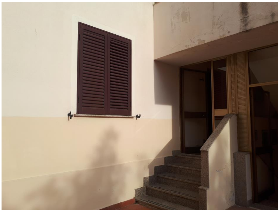
Foto 3 Ingresso all'unità immobiliare da via Montanara, da cortile interno B.C.N.C..
