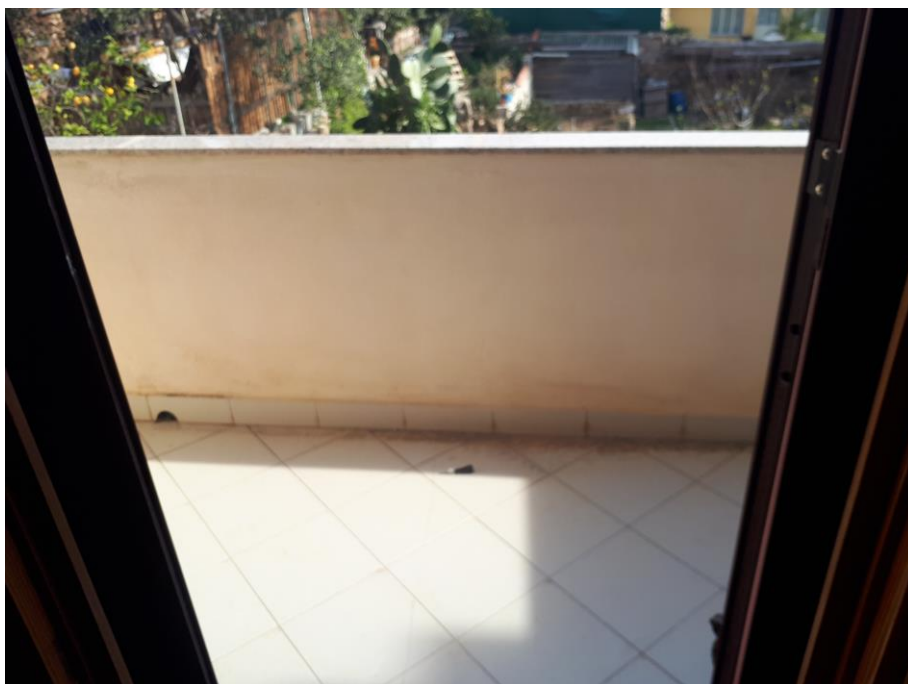
Foto 10 particolare del balcone;
