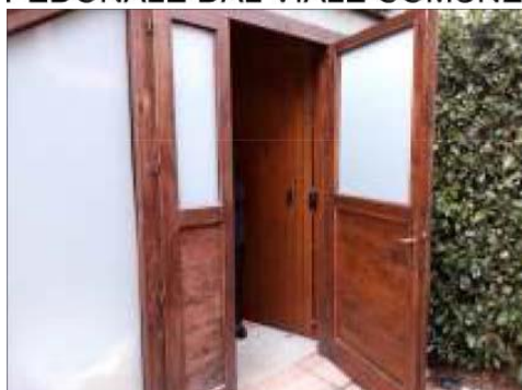
FOTO 15 - RIPOSTIGLIO SOTTO SCALA
