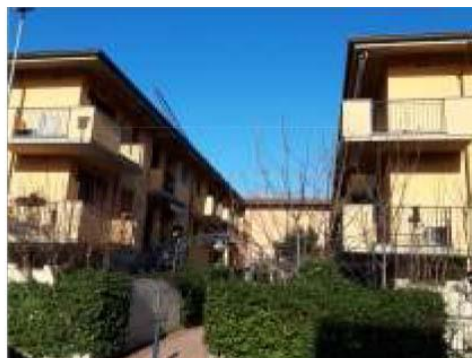
FOTO 2 - CONDOMINIO SAN ROCCO CON VIALE INTERNO
