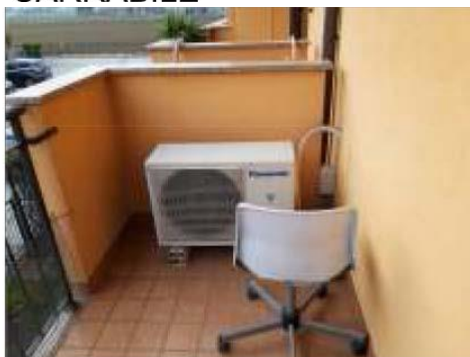
FOTO 40 - RAFFRESCAMENTO UNITA' ESTERNA
