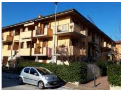
FOTO 1 - CONDOMINIO SAN ROCCO
