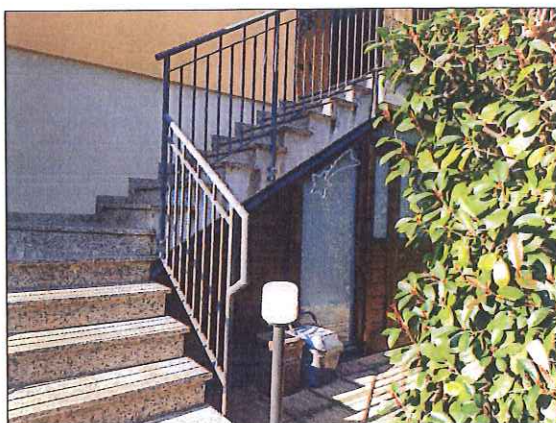
FOTO 5 - SCALA ESTERNA DI INGRESSO ALL'ABITAZIONE
