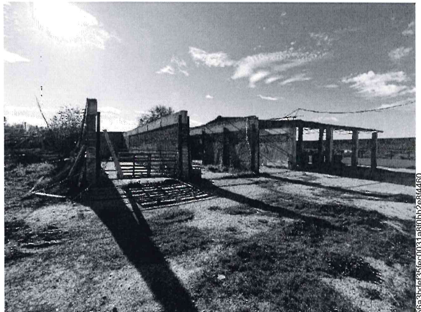
Foto 28 – P.Ila 292 – Prospetto Nord
