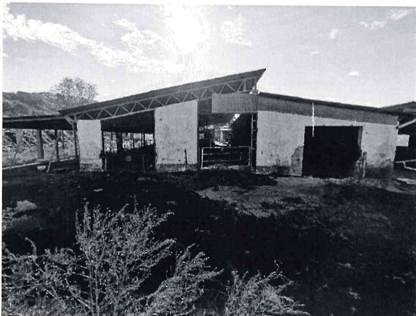
Foto 6 – P.Ila 291 – Prospetto Nord
